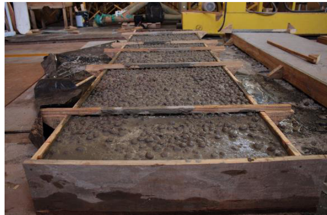
Figura 10 – Laje após regularização da capa.
