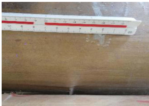
Figura 16 – Deslocamento local do bambu no centro da laje.
