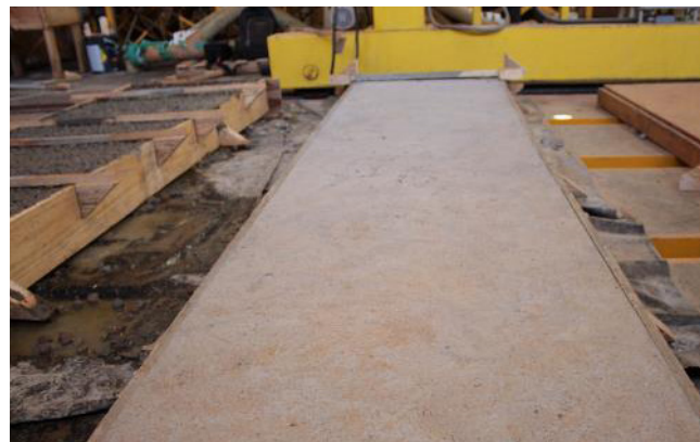
Figura 10 – Laje após regularização da capa.
