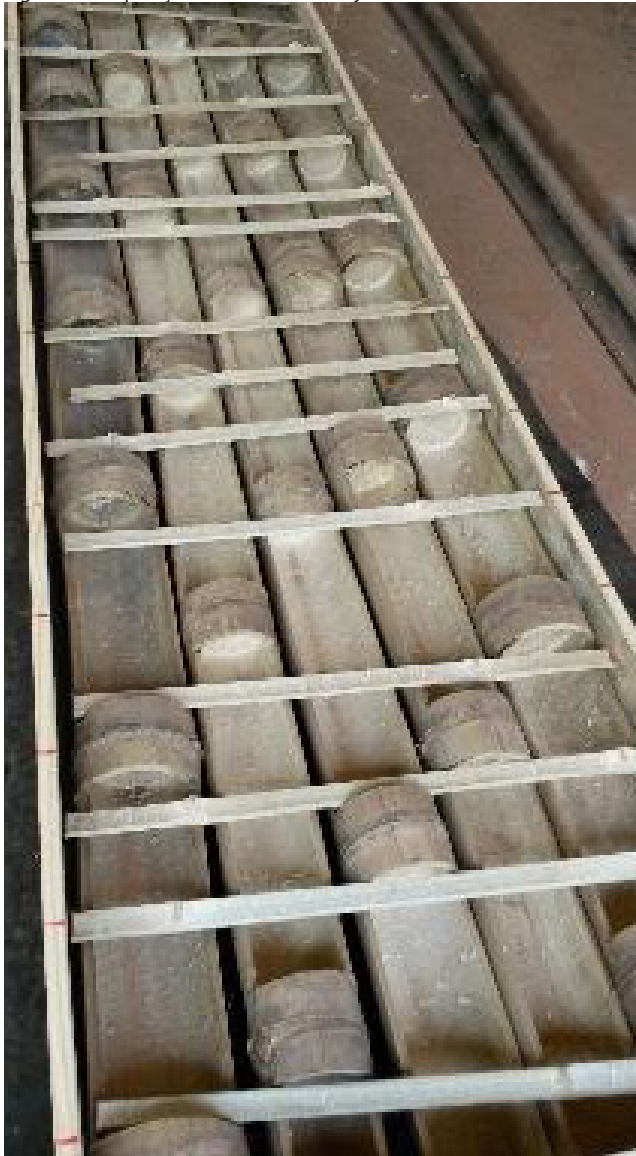
Figura 8 – Disposição das taliscas nas lajes com nós.
