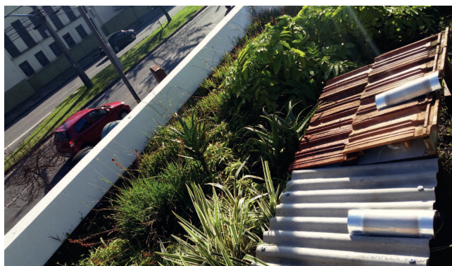
Figura 06: Conjunto de materiais instalado sobre a cobertura do Escritório Verde da UTFPR, com os termômetros instalados.
