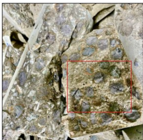
Figura 6. Rompimento do concreto na argila expandida.
