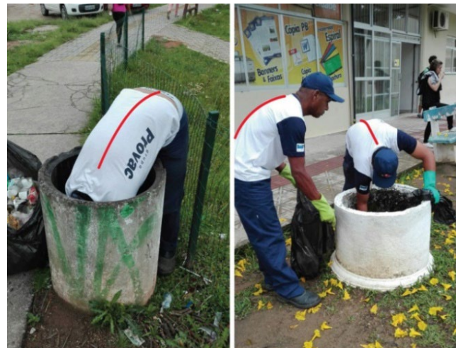
Figura 05- Postura dos trabalhadores na retirada de resíduos- Coletor de tubo de concreto Fonte: Prêve, 2017
