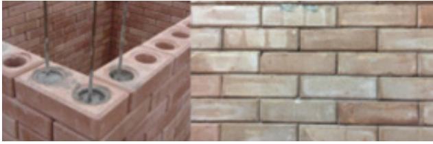
Figura 8: Tijolo Solo cimento da Casa Popular Eficiente da UFSM. Fonte: Elaboração dos autores (2021).
