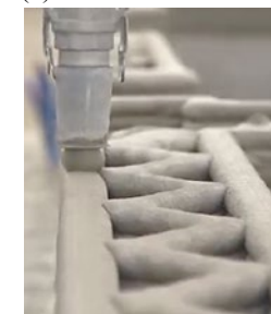
Figura 5: Vista externa (a) e interna (b) das casas e (c) impressão da parede. Fonte: ICON (2023).
