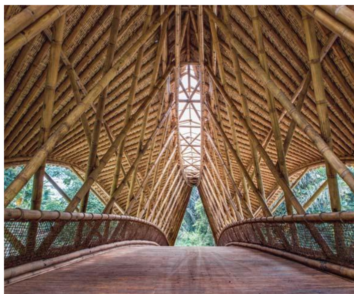
Figura 6: Estrutura em 3 camadas da cobertura. Fonte: JIN LOW (2022).
