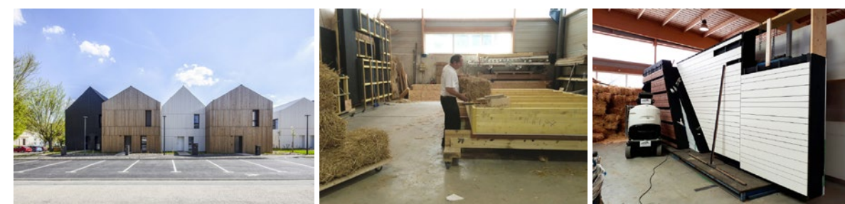
Figura 2: 13 maisons en bois-paille a) Fachada; b) Preenchimento dos painéis com palha; c) Painéis prontos. Fonte: NZI Architectes.
