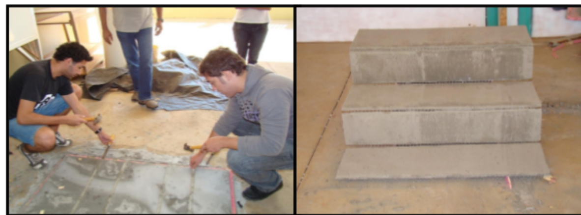
Figura 9.a: Desmolde da escada em argamassa armada com partículas de pneus como agregado leve.
