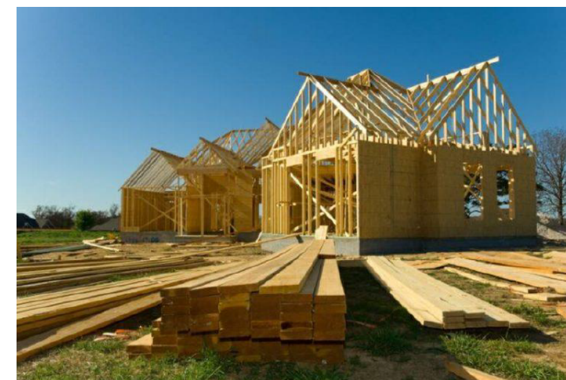
Figura 6: Residência em wood frame . Fonte: Techne, 2008.
