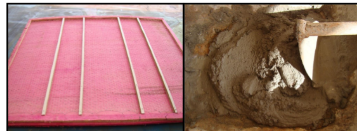
Figura 8.a: Molde da proposta de escada em argamassa armada com partículas de pneus como agregado leve. Fonte: Rodrigues, 2008.
