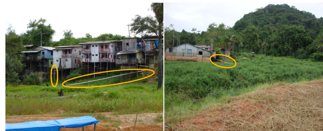
Figura 3 – Destinação local das águas servidas sem tratamento adequado. Casas localizadas no igarapé Mauixi na área dos bairros Graciliano Gonçalves (1) e Nova Esperança (2), respectivamente. Na presente foto, o rio está no período da vazante. Fonte: Autor.
