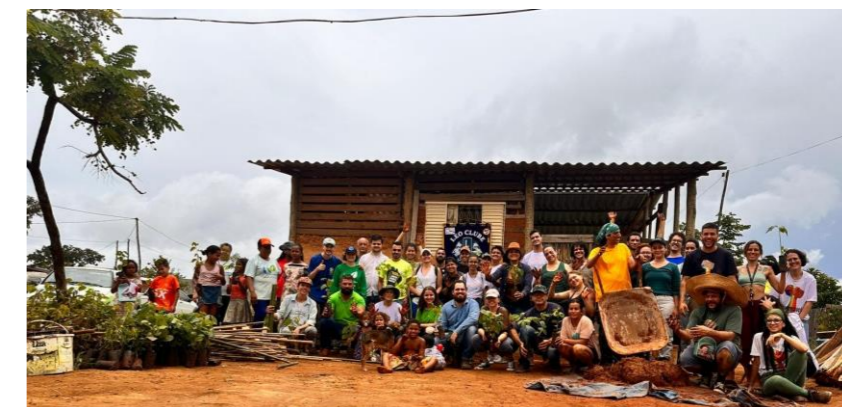
Figura 4: Colaboradores da comunidade nas obras da creche. Fonte: elaborado pelos autores.
