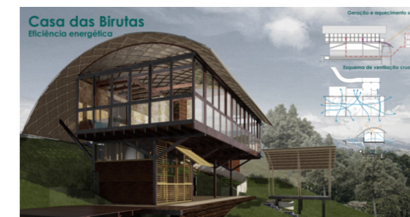
Figura 2: Casa das Birutas. Fonte: SustenArqui.
