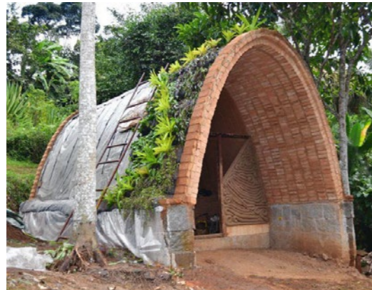
Figura 2: Cobertura de jardim vertical, Instituto Tibá. Fonte: https://www.tibario.com/projetos .
