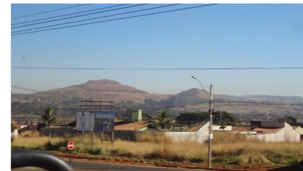
Figura 2: Altura do maciço de resíduos do aterro e relação com o entorno. Fonte: os autores (2020).
