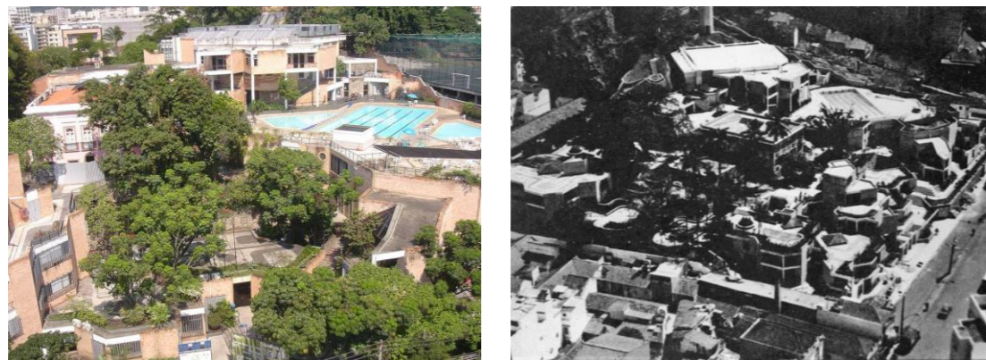
Figura 14 - Fragmentação formal como estratégia para fusão do edifício na encosta. SESC Tijuca, Rio de Janeiro, 1970. Arq. Sergio Jamel, Marco Coelho, Ângela Tâmega e Maria Freitas. Fonte: SESC Rio. Disponível em: https://www.sescorio.org.br/wp-content/uploads/2018/09/A%C3%A9reo.jpg . e https://revistaprojeto.com.br/wp-content/uploads/2020/09/sesc_tijuca-1-770x568.jpg . Acesso em 04/06/2021.
