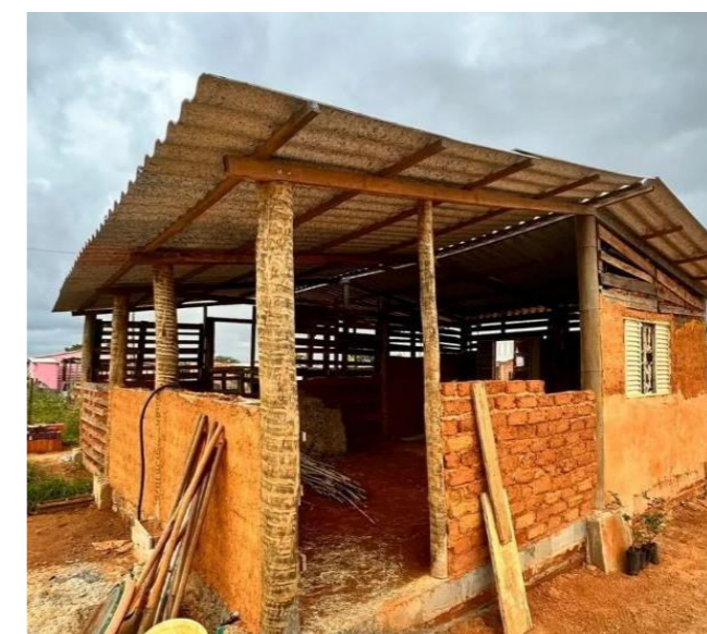
Figura 10: Creche sendo executada com técnicas bioconstrutivas. Fonte: elaborado pelos autores.
