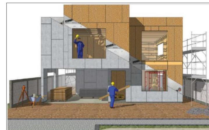
Figura 5: Residência em *wood frame*. Fonte: Tecverde, 2016.
