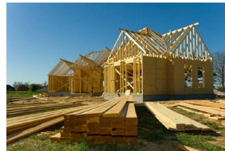
Figura 6: Residência em *wood frame*. Fonte: Techne, 2008.
