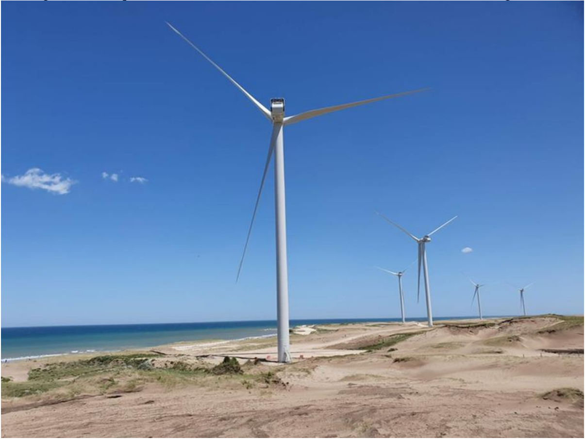
Figura 3 – Parque eólico Vientos de Necochea (Necochea, Buenos Aires, Argentina).
