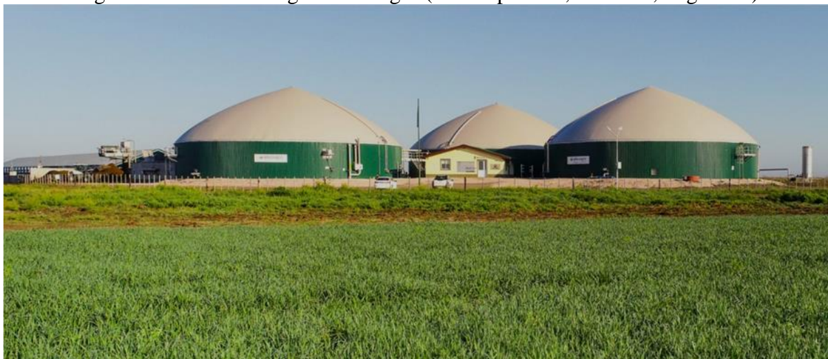
Figura 2 – Planta de biogás Adecoagro (Christophersen, Santa Fe, Argentina).
