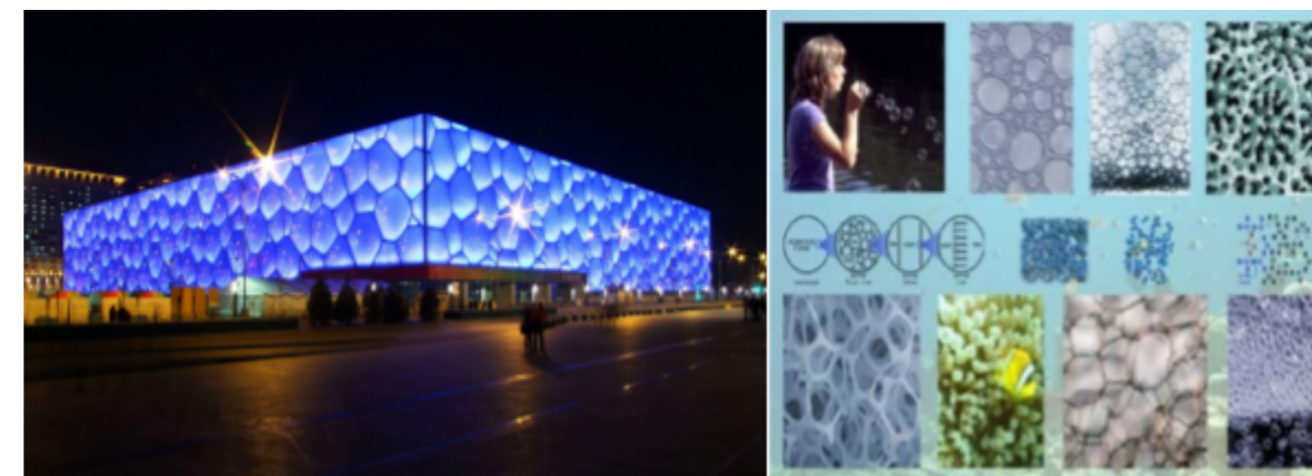
Figura 6: Watercube – Centro Nacional de Natação. Fonte: PTW Architects, 2008.
