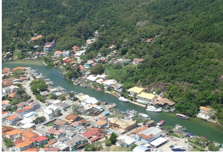
Figura 61 - Ocupações em APP's e margens da Barra da Lagoa
