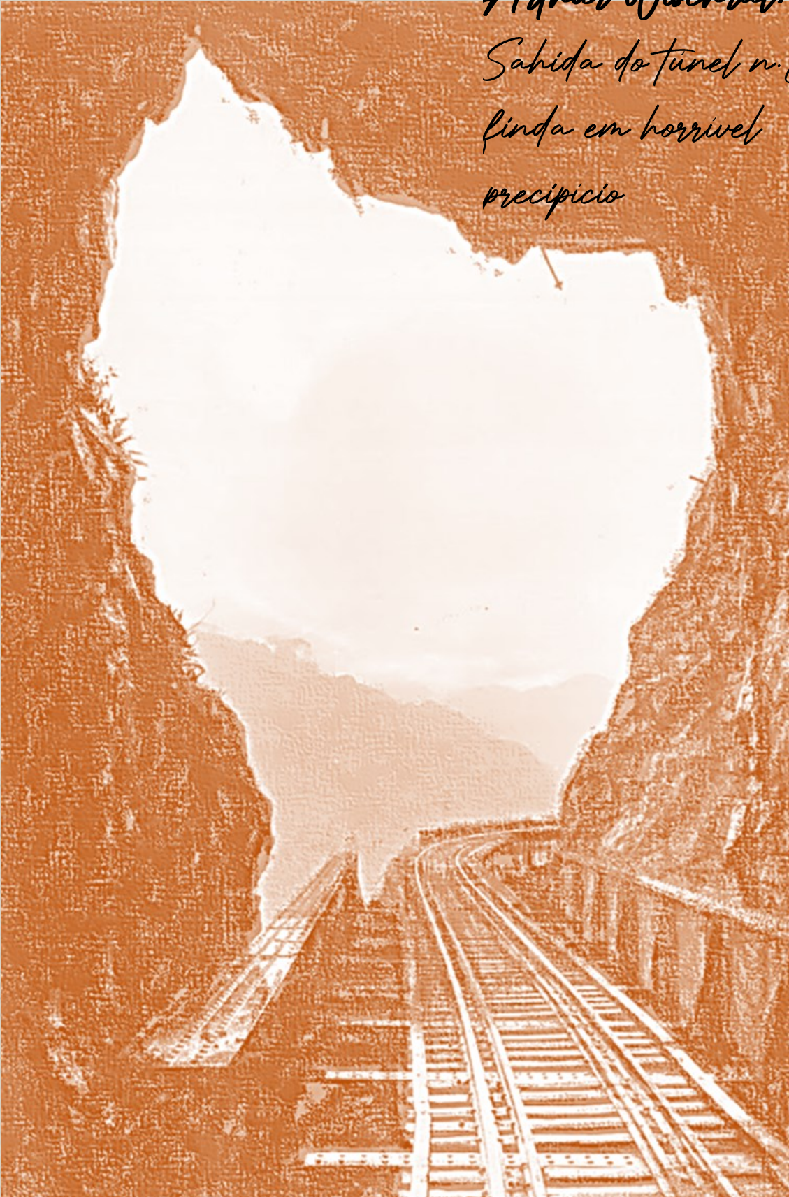
Figura 2 – Túnel ferrovia Curitiba Paranaguá. Fonte: Wischral (1929).
