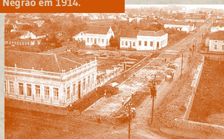
Figura 76 – Obra de pavimentação na rua João Negrão em 1914.
