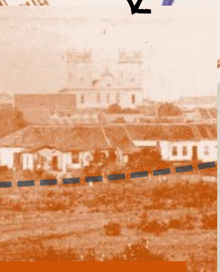
onde atualmente está a praça, a água vinha através dos telhados
