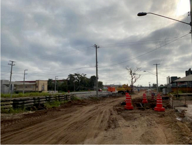
Figura 28 - Escavadeira sendo utilizada para preparação do solo nas obras de duplicação da BR-280.
