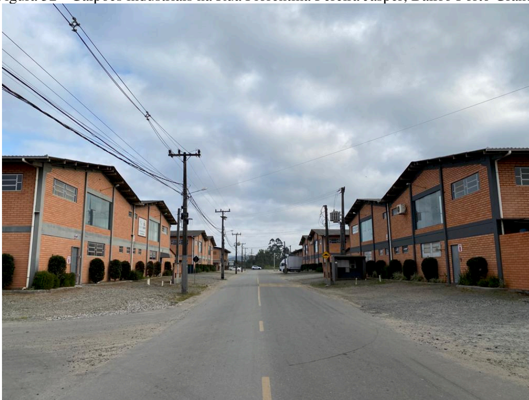
Figura 52 - Galpões industriais na Rua Florentina Pereira Jasper, Bairro Porto Grande
