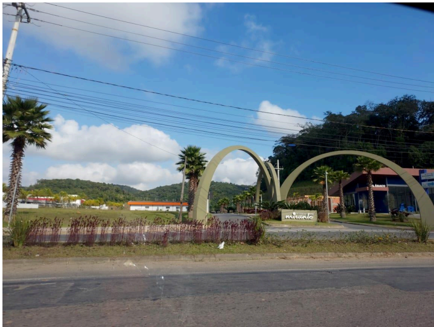
Figura 32 – Portal de entrada do Loteamento Reserva do Mirante
