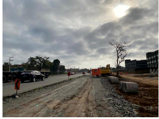
Figura 29 - Preparação do solo nas obras de duplicação da BR-280.
