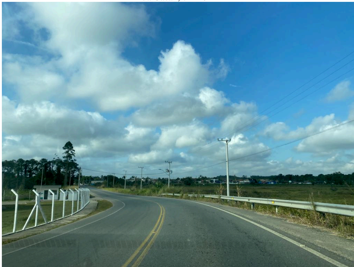
Figura 47 - Rodovia Rio do Morro na altura da Estação de Tratamento de Esgoto da Casan, em 2022
