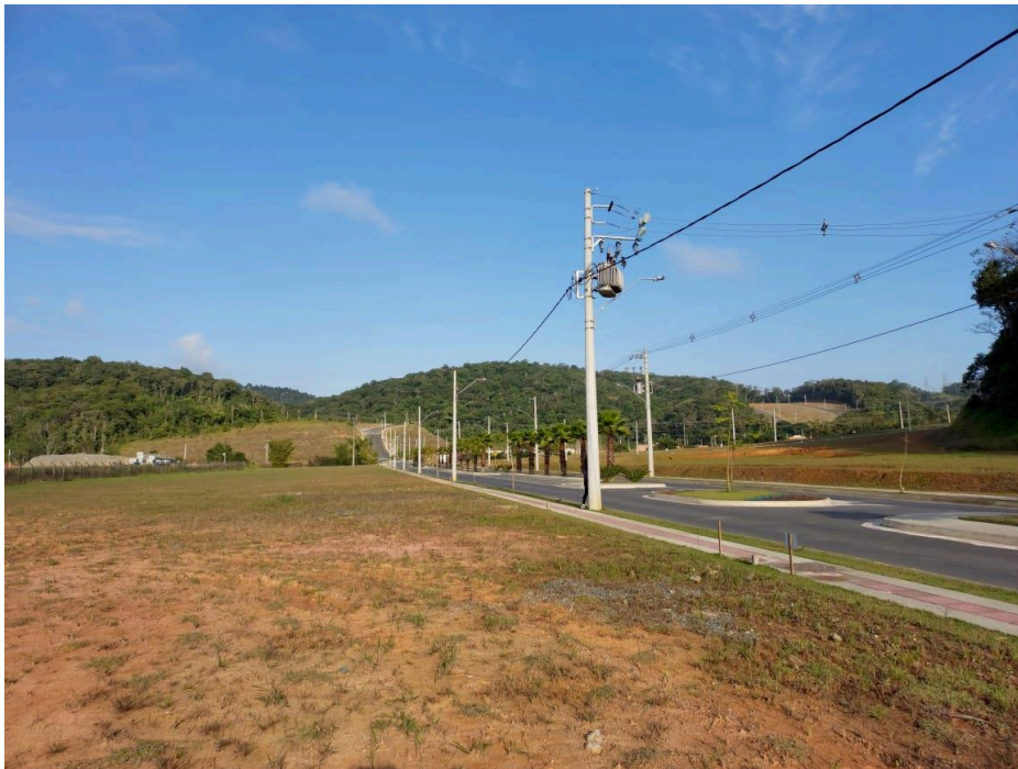
Figura 33 – Estrutura de iluminação e pavimentação em lotes sem edificações no Loteamento Reserva do Mirante
