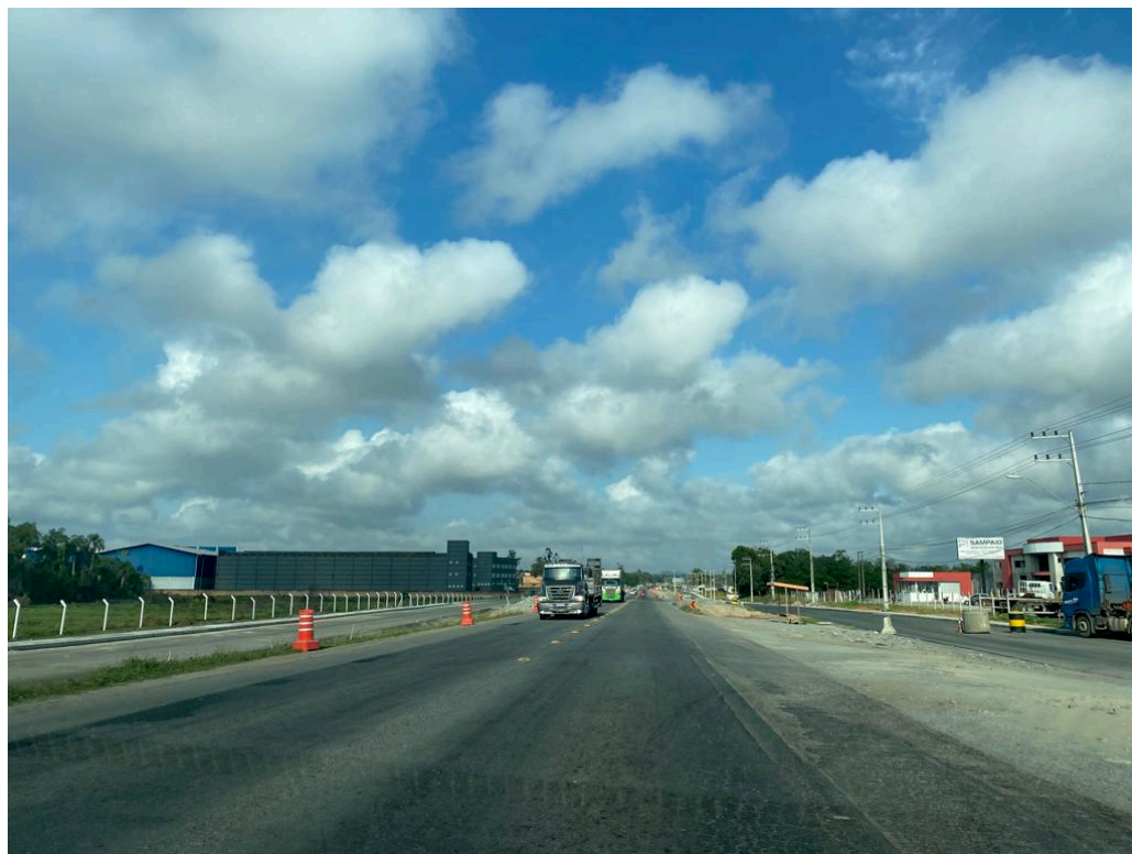
Figura 49 - Obras de duplicação na Rodovia BR-280
