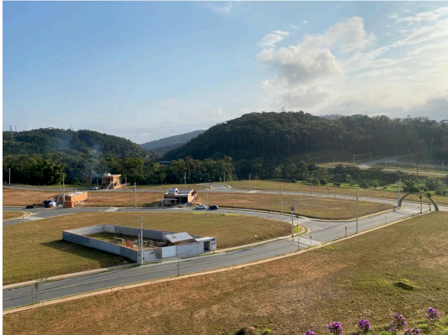
Figura 31 – Construção das primeiras residências do Loteamento Reserva do Mirante.
