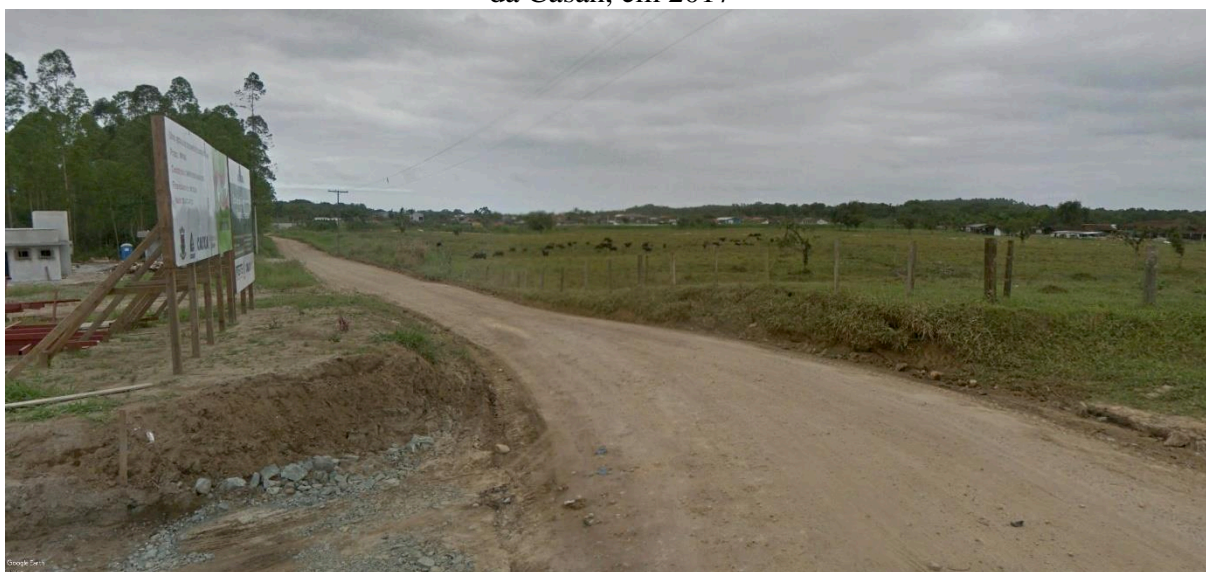
Figura 48 - Rodovia Rio do Morro na altura da Estação de Tratamento de Esgoto da Casan, em 2017
