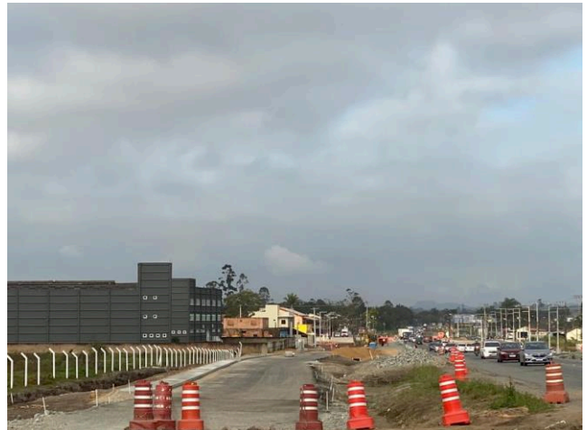
Figura 27 - Obras de duplicação da BR-280, ao lado da entrada do Instituto Federal Catarinense.
