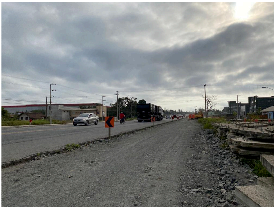
Figura 41 - Preparação do solo para a pavimentação da pista duplicada da BR-280
