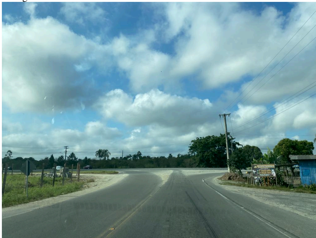
Figura 44 – Encontro entre a Rodovia Rio do Morro e a Rodovia BR-280
