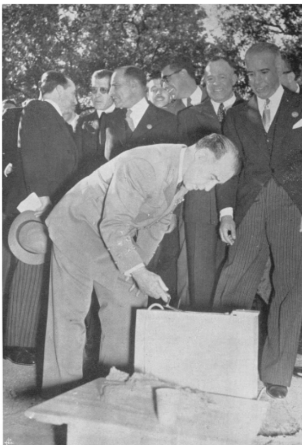
O Chefe do Estado, procede ao lançamento da primeira pedra, para o novo edifício do I. M. T. Le Président de la République Portugaise posant la pierre fondamentale, pour le nouveau édifice de l'Institut de Medecine Tropicale — The President of the Portuguese Republic layin the foundation stone for the new building of the Tropical Medicine Institute
