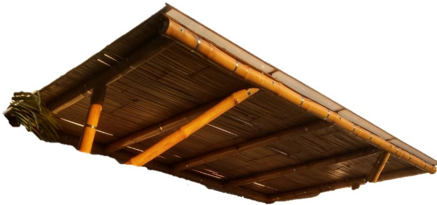
(b) Detalhe – vista inferior do forro
