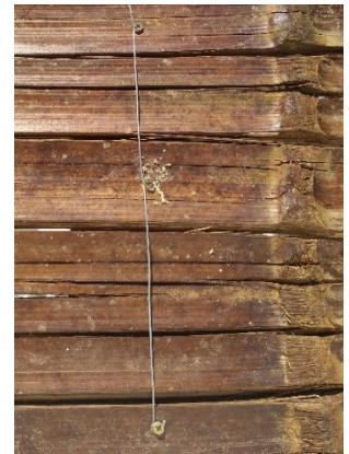
(c) Detalhe – fixação das esterillas
