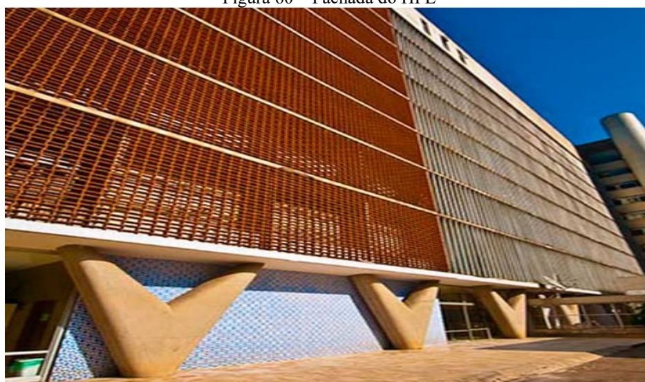
Figura 60 – Fachada do HFL
