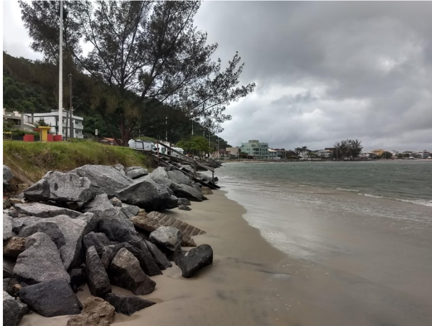
Figura 9 - Impacto sobre a faixa de areia no município de São Francisco do Sul, o qual demonstra a supressão de feições do perfil da praia caracterizada pela praia reduzida
