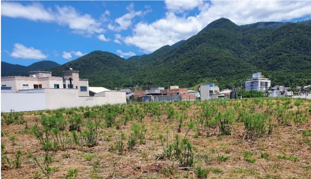
Figura 10 - WCV-FS como tratamento secundário de esgoto doméstico gerado em loteamento multifamiliar localizado em Palhoça/SC.
