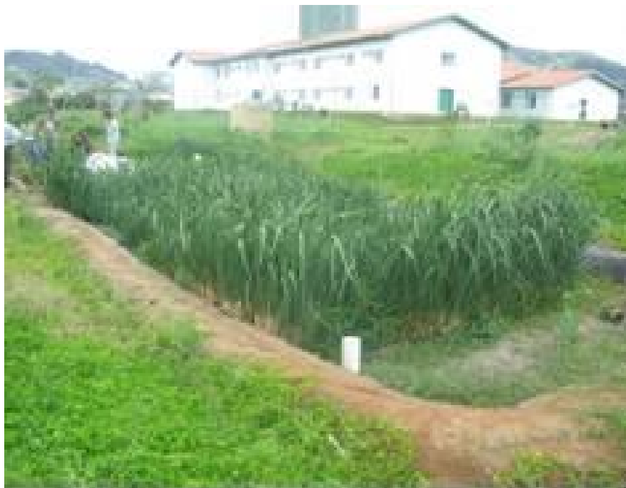
Figura 13 - WCH como tratamento secundário de esgoto sanitário gerado em pousada rural localizada em Tubarão/SC.
