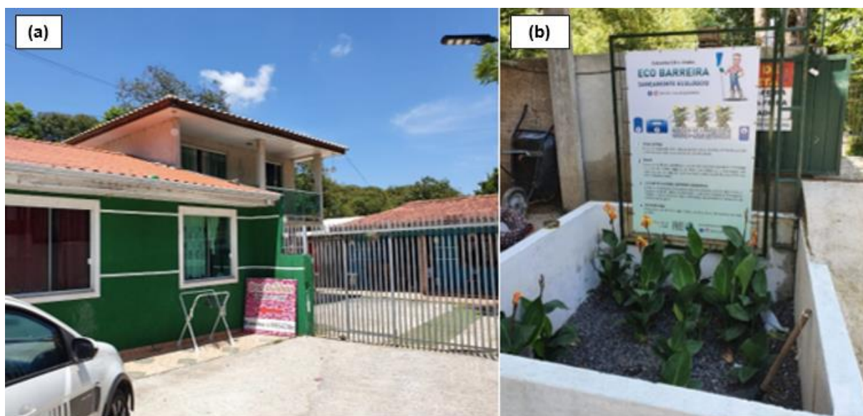
Figura 28 - Residências atendidas pelo sistema descentralizado em Colombo/PR (a) e WCH que compõe o arranjo tecnológico do sistema (b).
