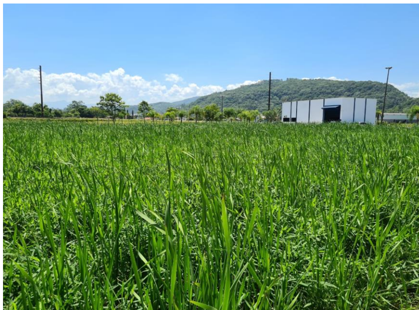
Figura 12 - WCV como tratamento secundário de esgoto sanitário de bacias de escoamento de duas zonas da cidade, ou “bairro-cidade”, localizado em Meleiro/SC.
