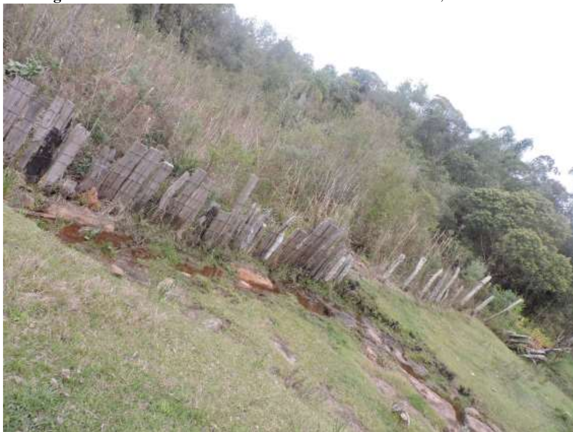
Fotografia 38: Cerca circundante de madeira com fios de arame, Faxinal do Salto.
