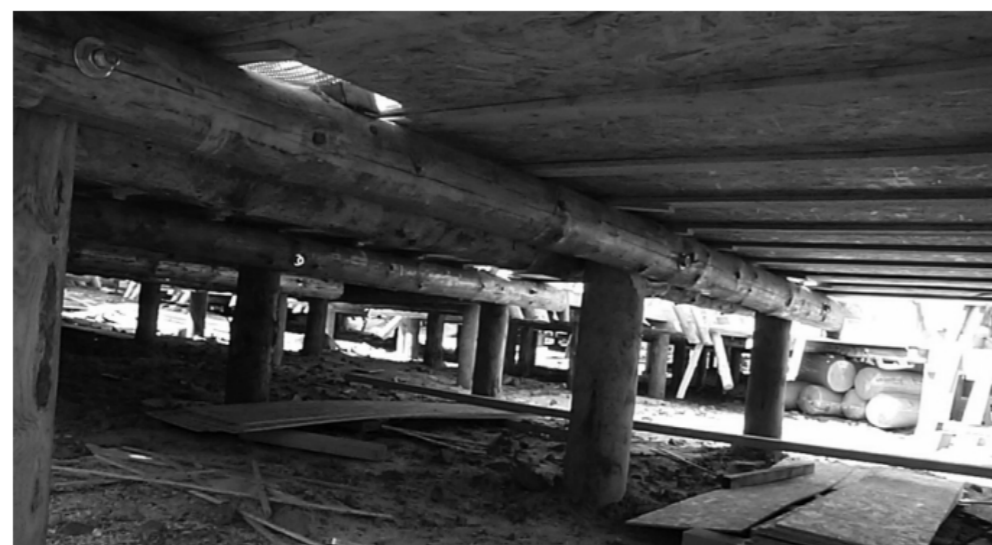
Figura 2: Vista da ligação entre os postes de fundação e as linhas. Fonte: Chrisp, Cairns e Gulland (2003)
