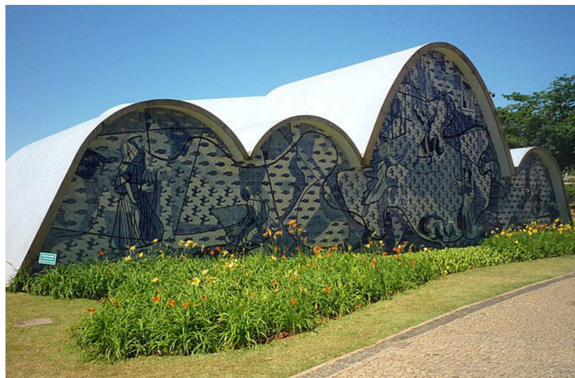
Figura 98: Igreja da Pampulha vista posterior.
