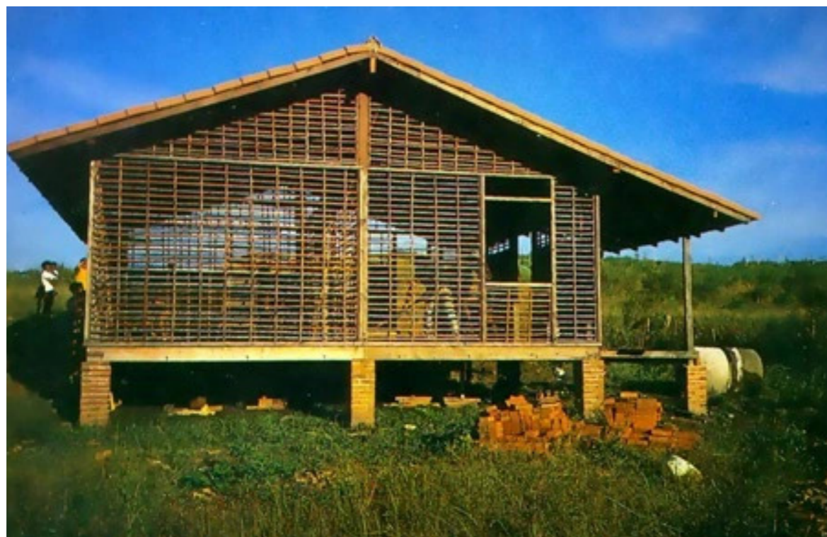
Figura 85: Paredes exteriores da Casa do Nilo.
