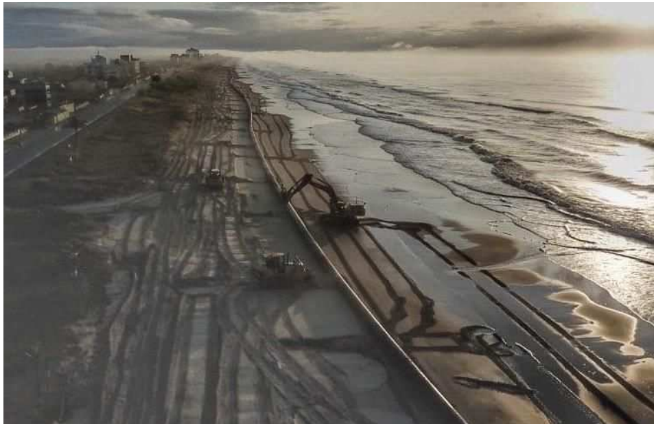
Figura 49 - Serviço de movimentação de sedimentos após alimentação artificial
