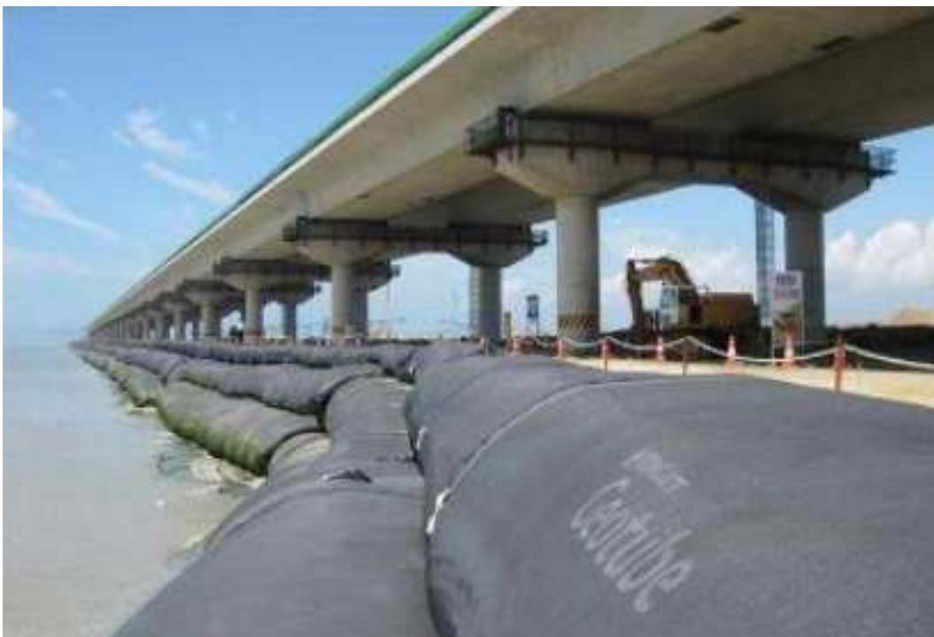
Figura 11 - Geotubos
