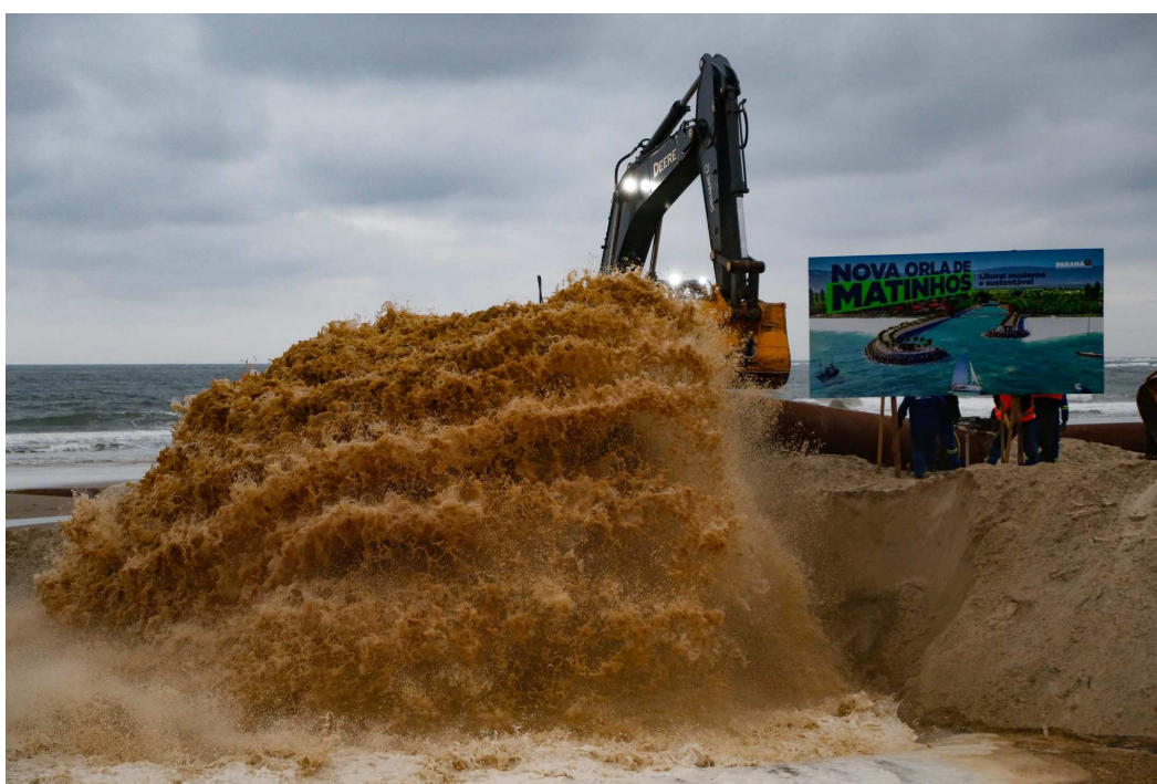
Figura 48 - Bombeamento da areia dragada para a área de deposição
