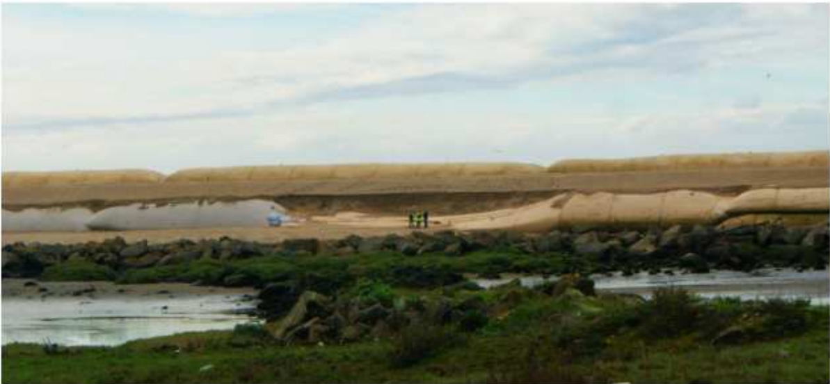
Figura 15 - Reforço de restinga com geotubos
