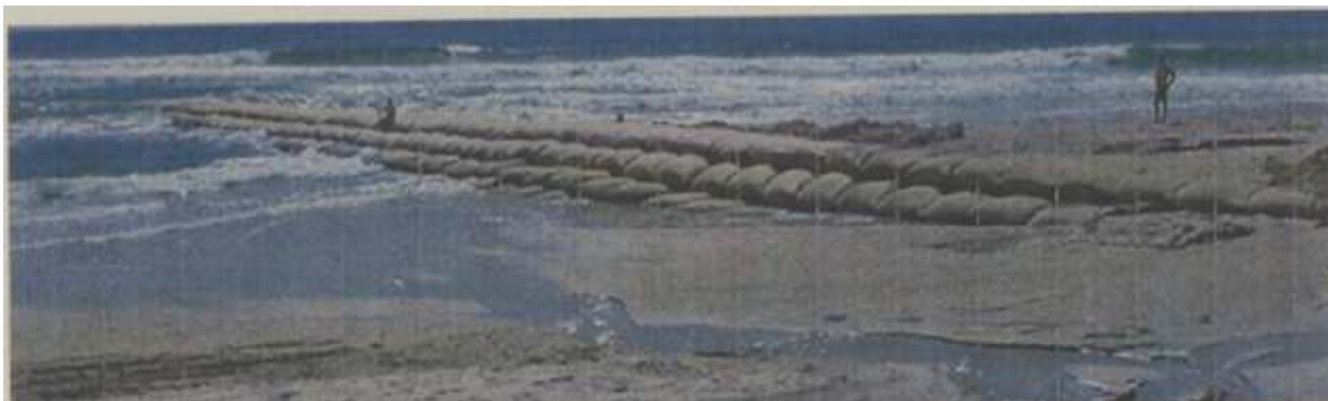
Figura 19 - Espigão formado por geossintéticos em Maroochydore, Austrália
