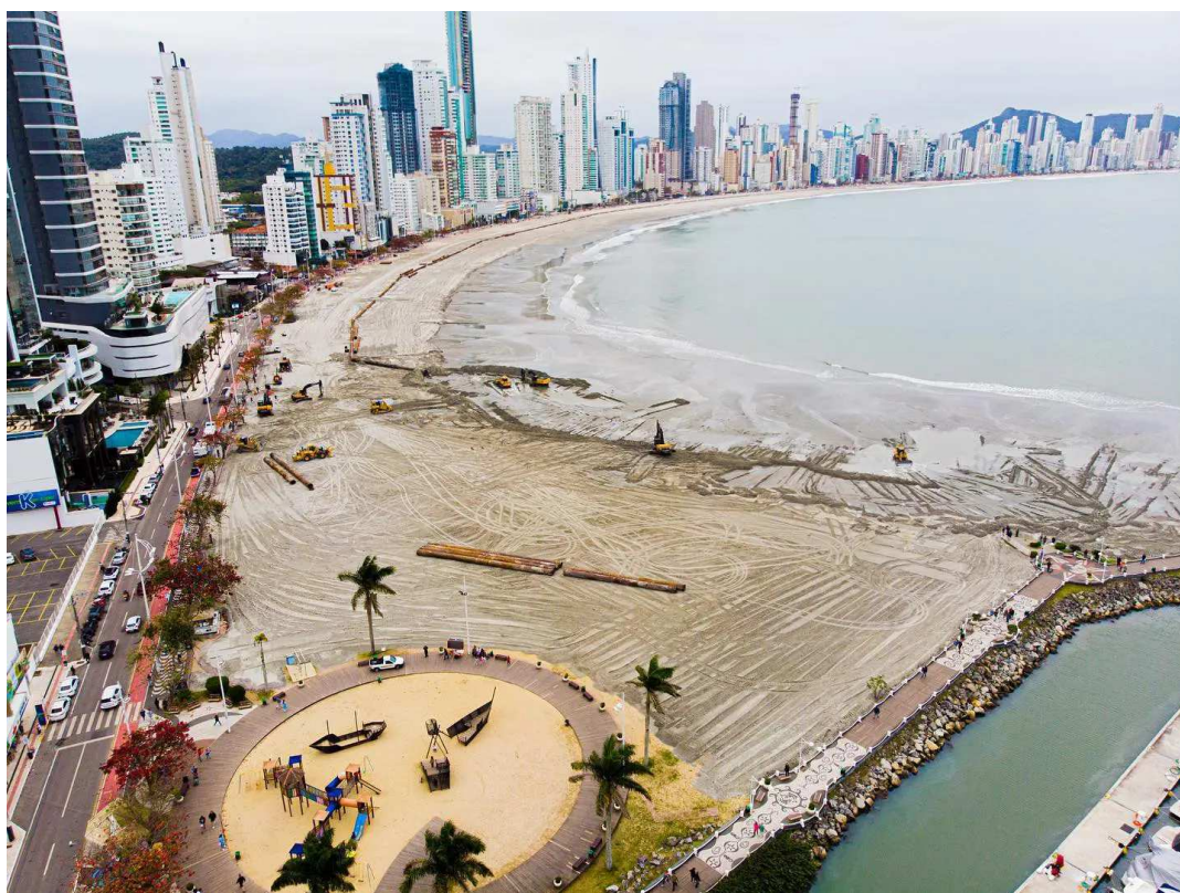
Figura 6 - Engordamento artificial da praia de Balneário Camboriú, SC
