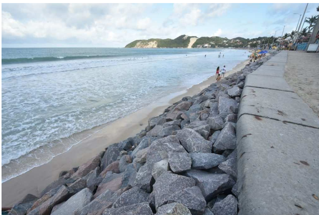
Figura 1 - Obra longitudinal aderente de enrocamento na orla de Natal, RN
