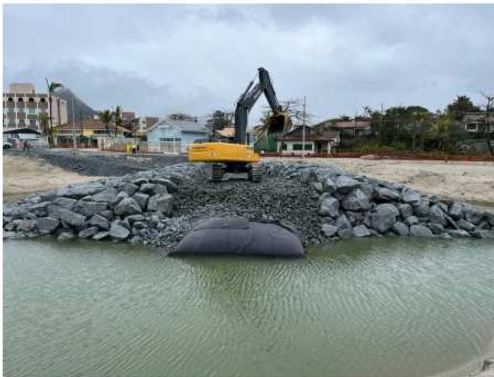
Figura 46 - Cobrimento dos geotubos com rochas
