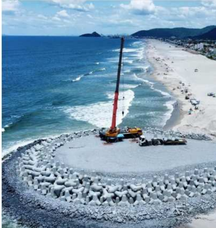
Figura 44 - Processo final de construção da carapaça rígida em Matinhos
