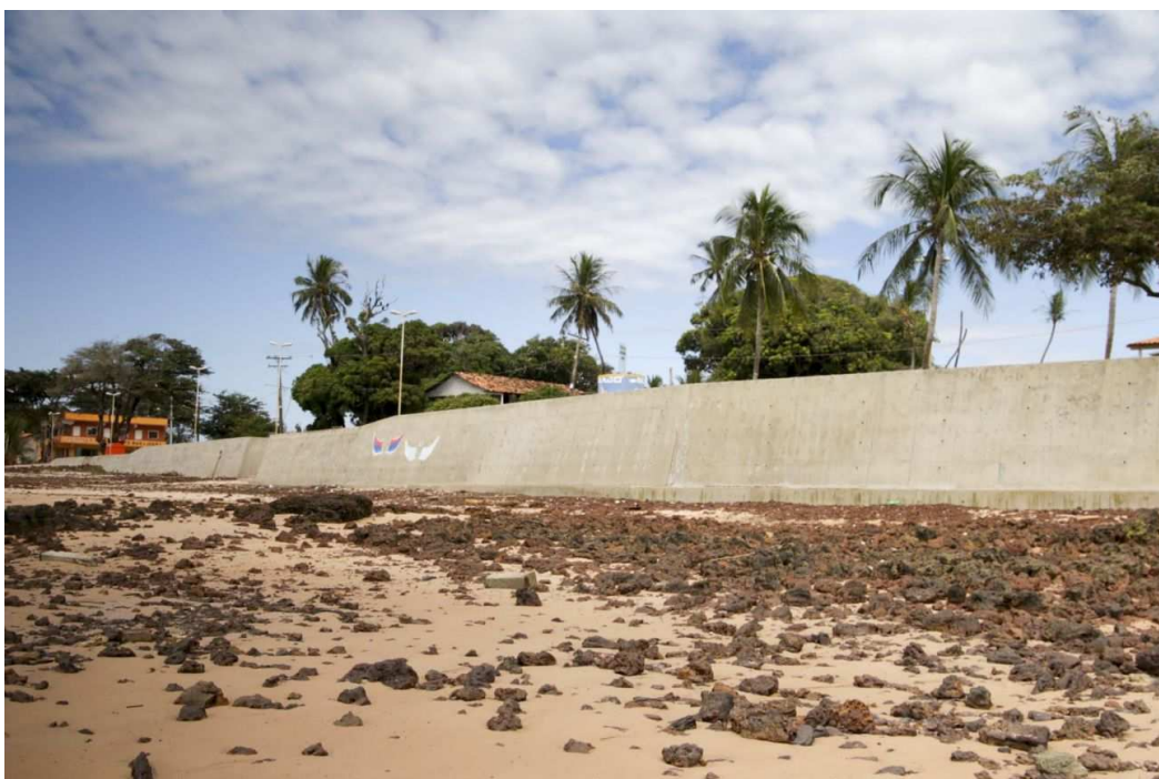
Figura 2 - Paredão de revestimento para contenção em Salvaterra, PA
