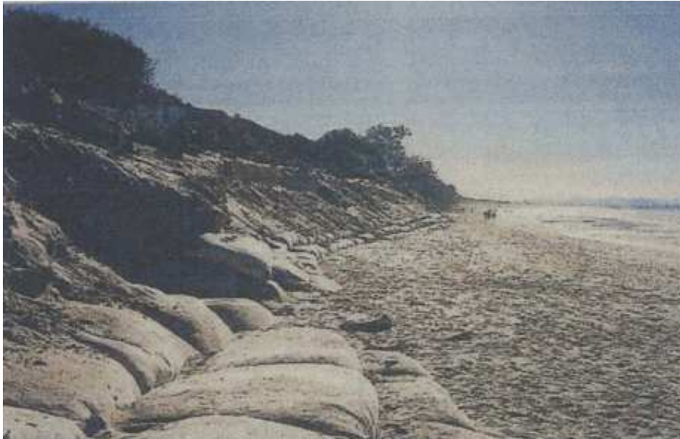
Figura 18 - Reforço de talude superficial com geobags na Austrália
