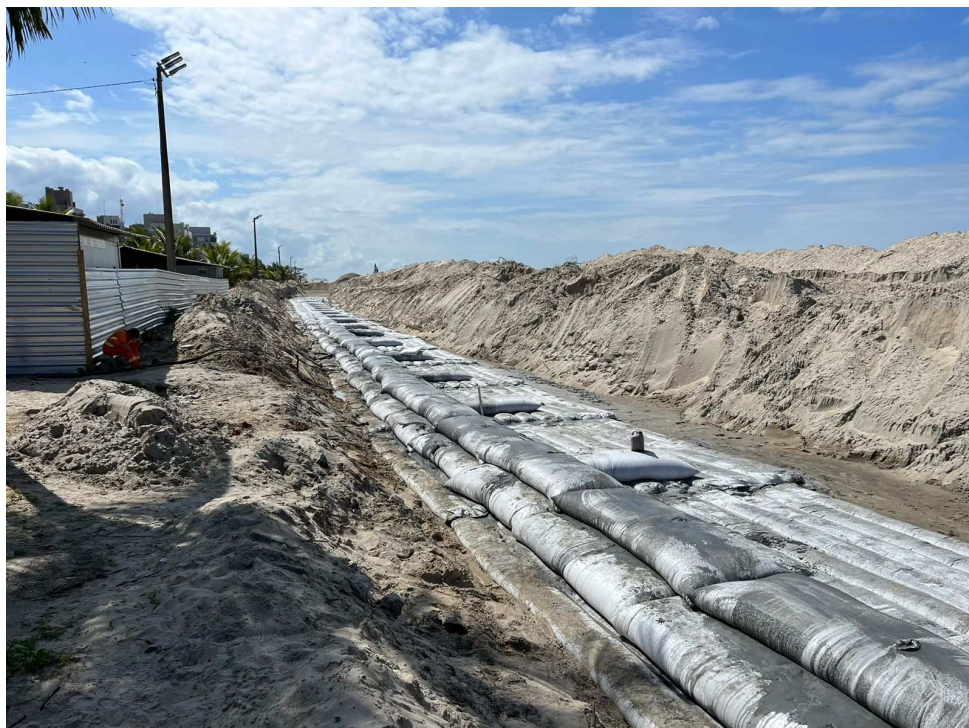
Figura 51 - Instalação de geobags na faixa de areia em Matinhos
