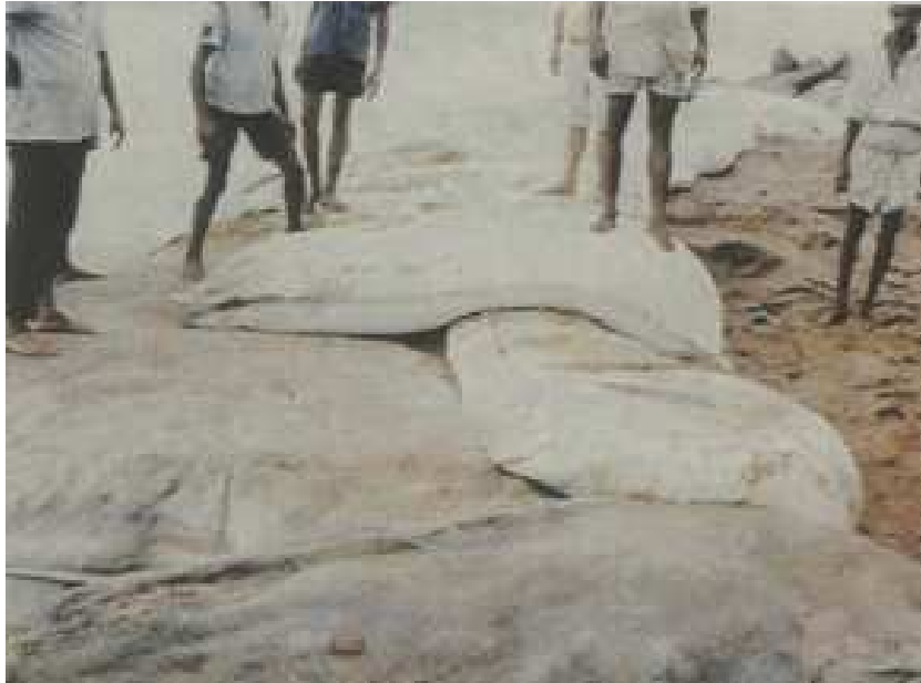
Figura 17 - Solução temporária com geobags no Sri Lanka
