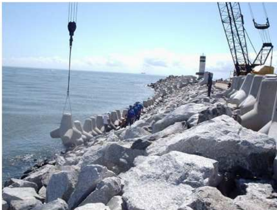
Figura 27 - Carapaça de enrocamento e tetrápodes
