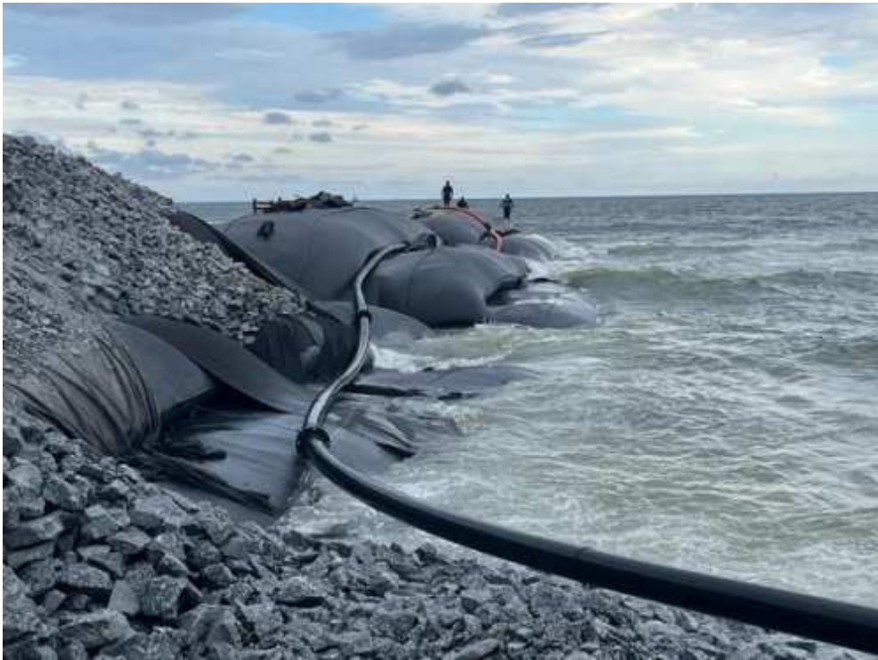
Figura 45 - Enchimento dos geotubos por bombeamento hidráulico
