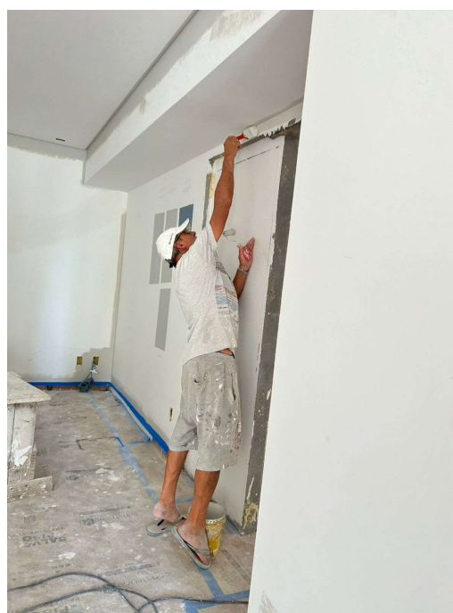
Figura 36 - Pintura na Obra 1
