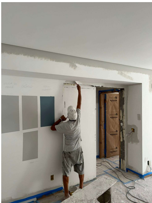
Figura 37 - Pintura na Obra 1
