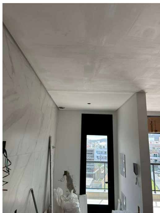
Figura 35 - Forro de gesso na Obra 3.
