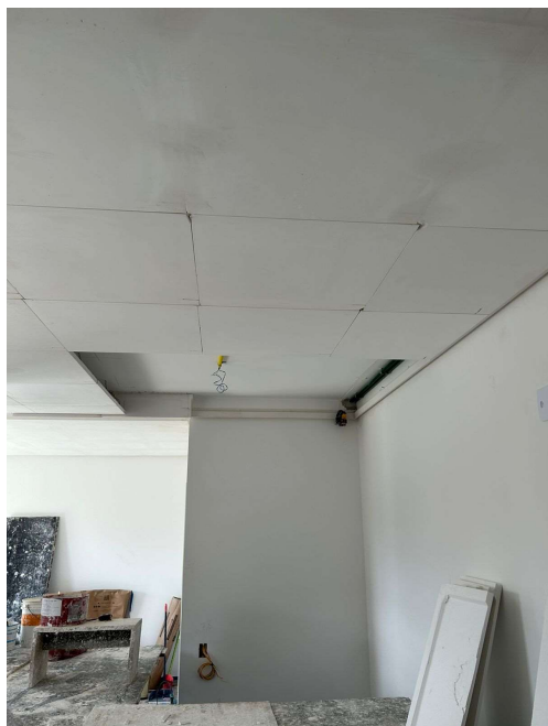
Figura 33 - Forro de gesso na Obra 3.
