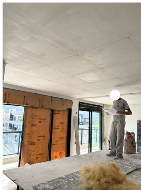
Figura 34 - Forro de gesso na Obra 3.
