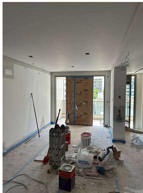
Figura 38 - Pintura na Obra 1
