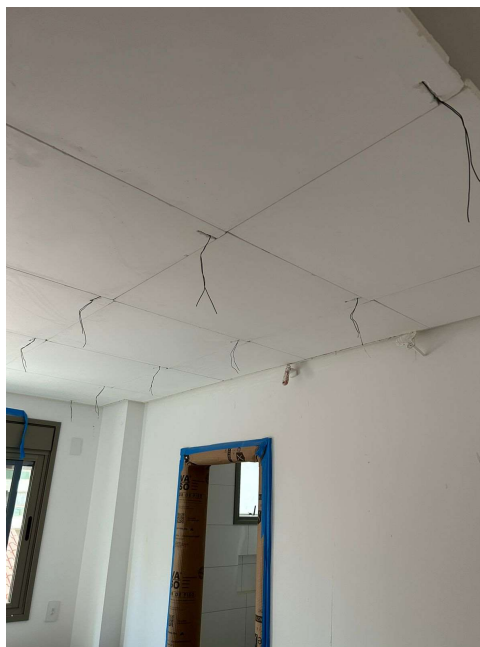
Figura 39 - Forro de gesso na Obra 1
