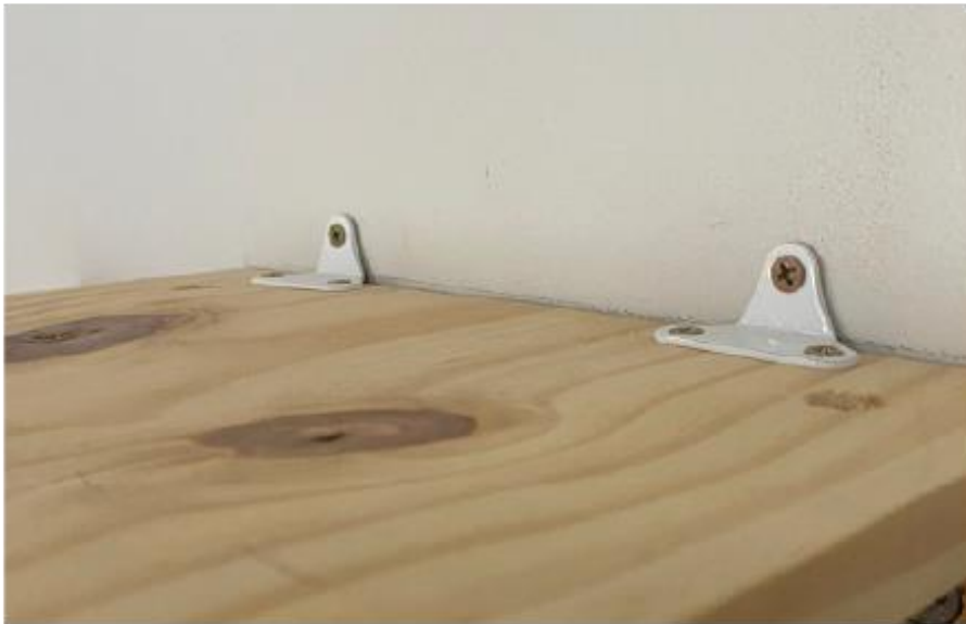
Figura 22: Cantoneira fixada na parede modelo final
