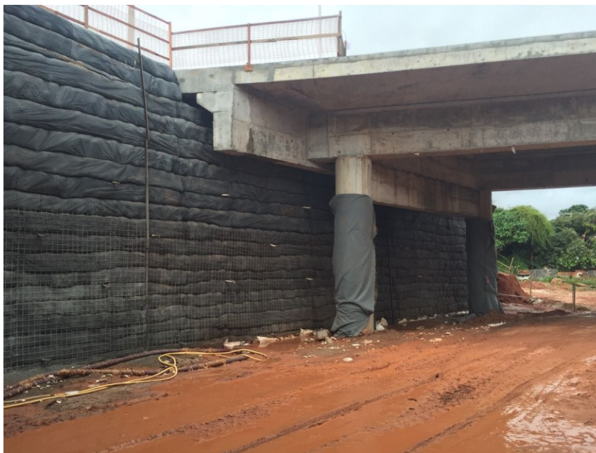
Figura 3- Construção do solo envelopado
