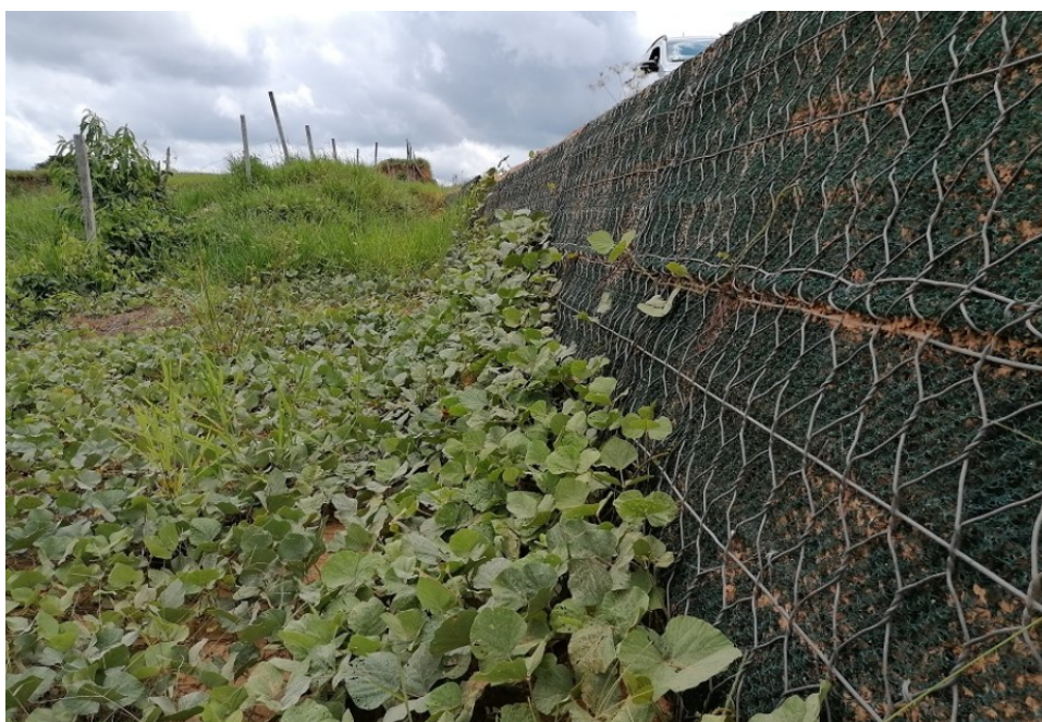
Figura 6- Estrutura de contenção Terramesh® verde
