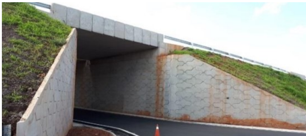
Figura 9- Terra Armada em obra rodoviária
