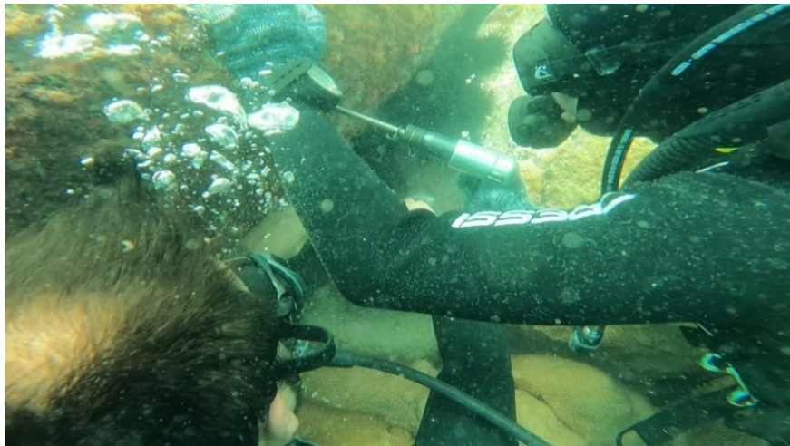
Figura 13 - Martelete pneumático em operação submersa.
