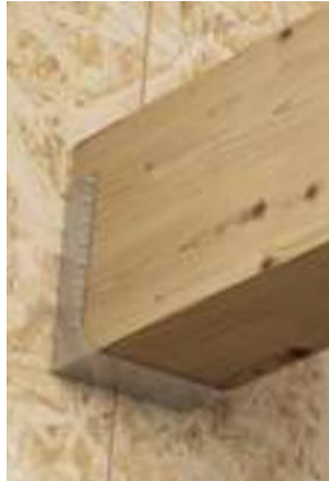
Figura 73 - Estribos metálicos com asas internas
