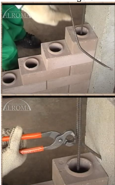
Figura 117 - Instruções do bloco de solo cimento 05
