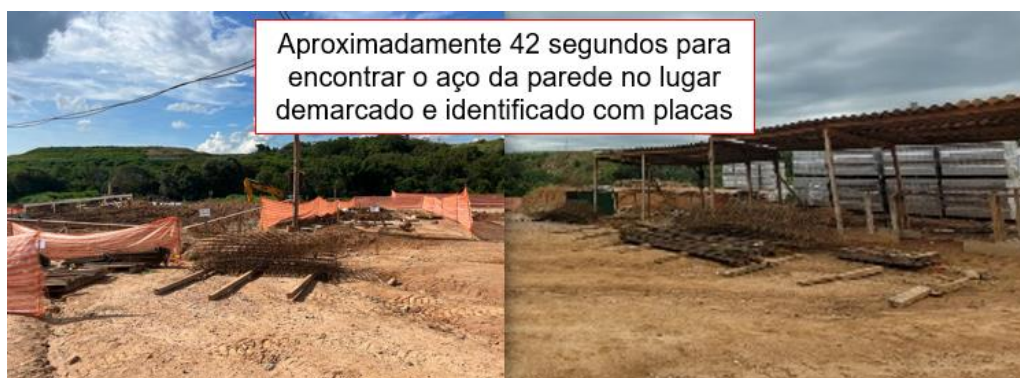
Figura 38 - Central de aço após as alterações
