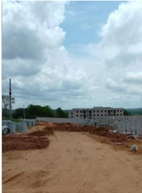
Figura 43 - aduelas após a drenagem externa
