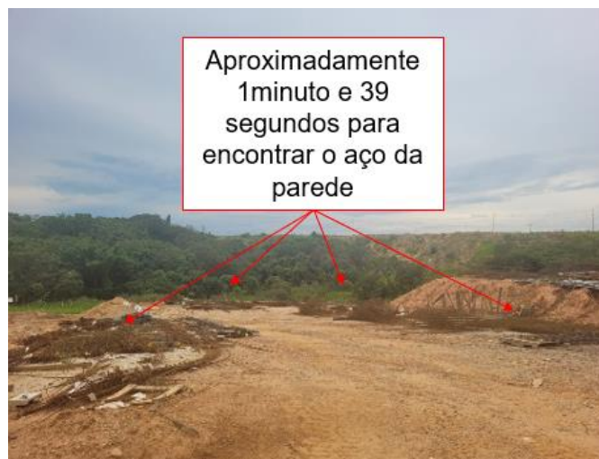
Figura 37 - Central de aço antes das alterações
