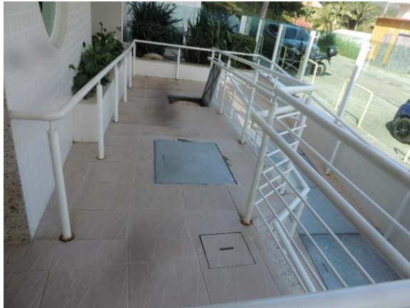
Figura 28 – Vista geral da ETE 2
