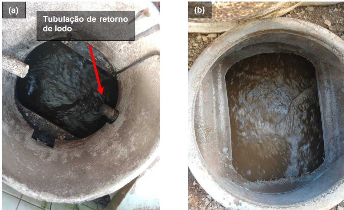
Figura 34 – (a) Tanque de aeração, acesso 1; e (b) tanque de aeração, acesso 2.
