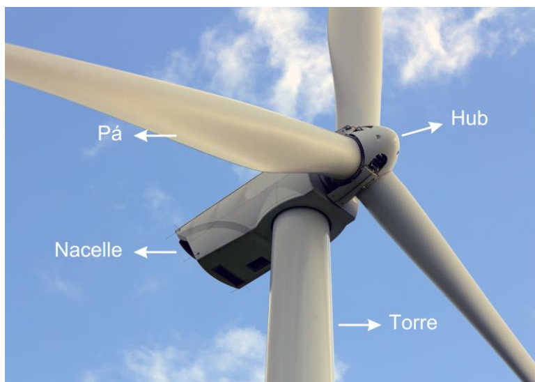
Figura 1 – Componentes de um aerogerador
