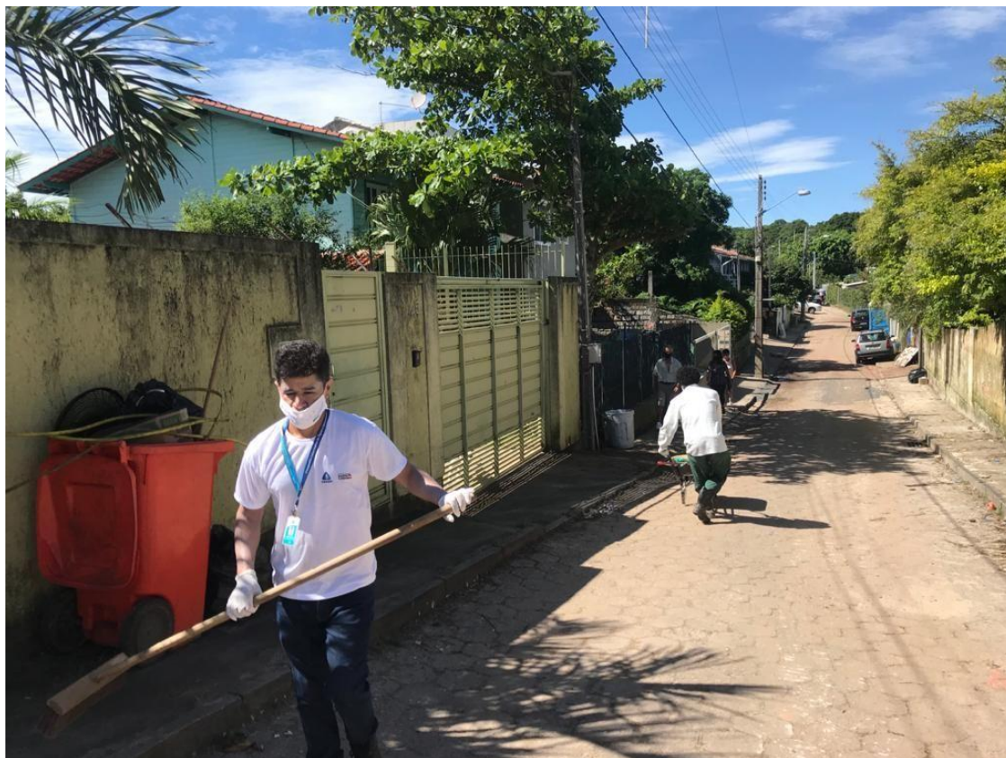
Figura 7: Recuperação das residências na Servidão Manoel Luiz Duarte.
