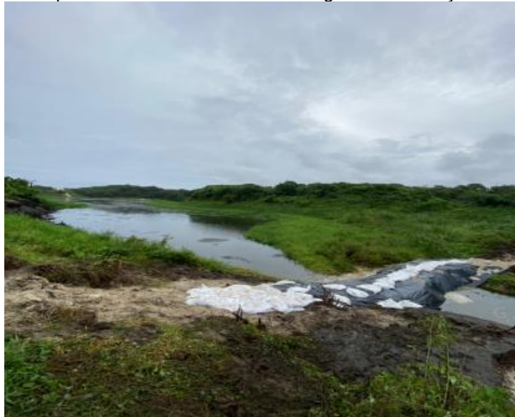
Figura 28. Sacos de areia utilizados para cessar o vazamento contínuo, pós rompimento do talude que sustentava a LEI da ETE Lagoa da Conceição
