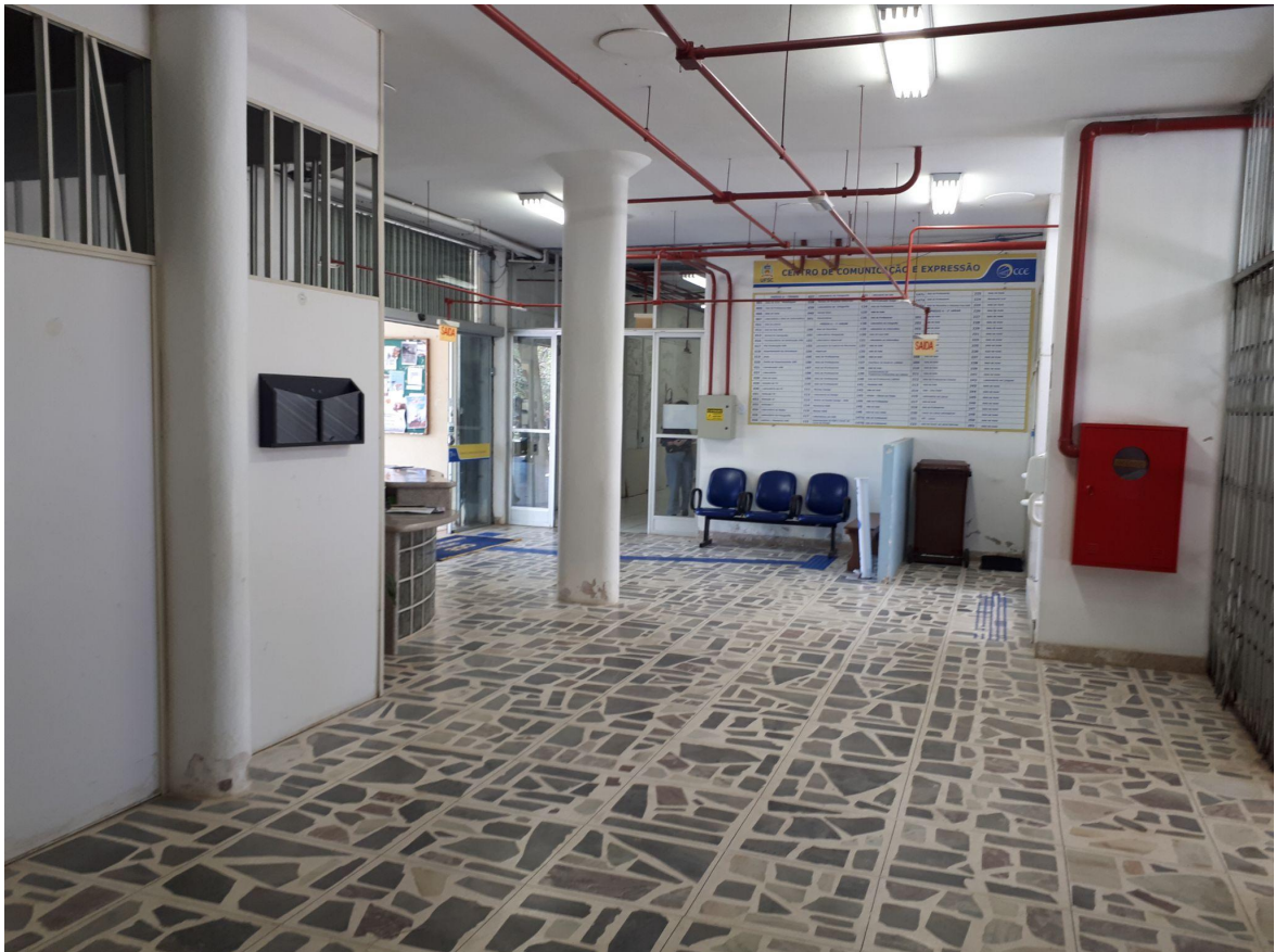
Figura 43 - Bloco A, CCE, Térreo
