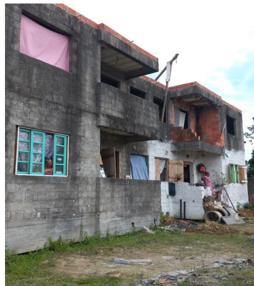
Figura 8 – Vista de um dos prédios da segunda ocupação
