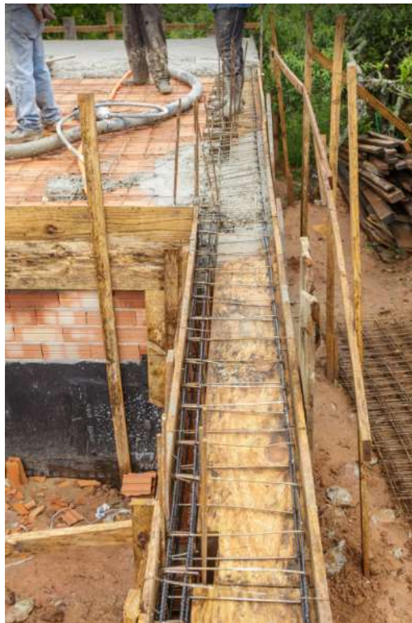
Figura 11 - Construção de casa, utilizando GFRP para armação longitudinal de vigas e lajes, Curitiba/PR Fonte: Haizen Group, acesso em 13/06/2022
