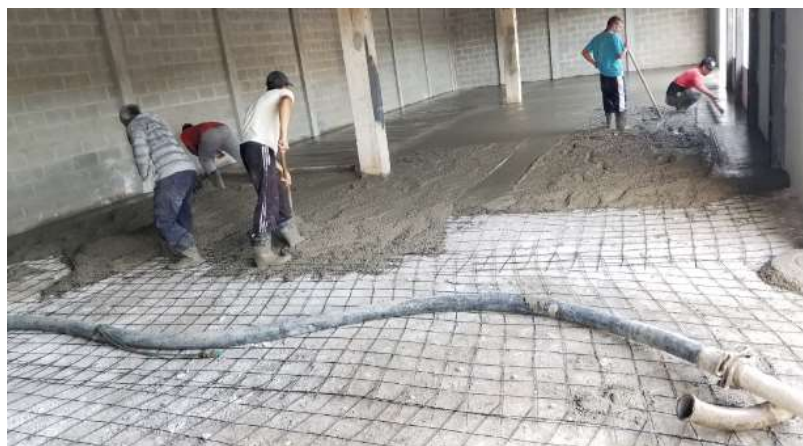
Figura 9 - Piso industrial com aplicação de malha GFRP, Curitiba/PR Fonte: Haizen Group, acesso em 13/06/2022
