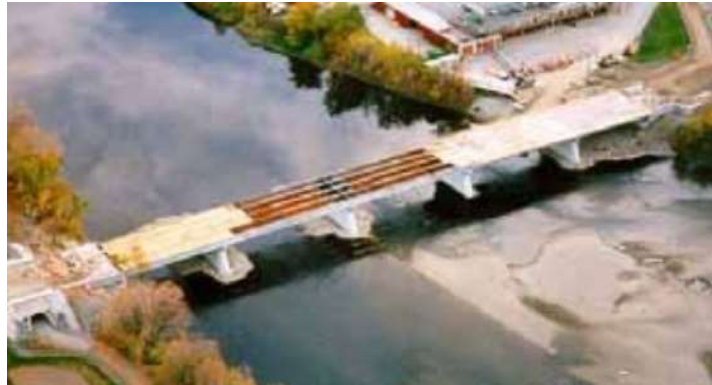
Figura 8 - Ponte Joffre, utiliza armadura CFRP, localizada em Quebec, Canadá Fonte: CAN/CSA-S806-12 (2017)
