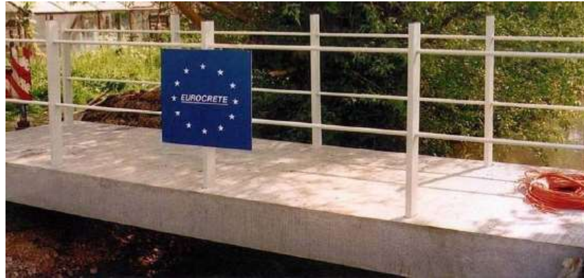
Figura 5 - Passarela em concreto armado com FRP, projeto Eurocrete Fonte: FIB Bulletin 40 (2007)
