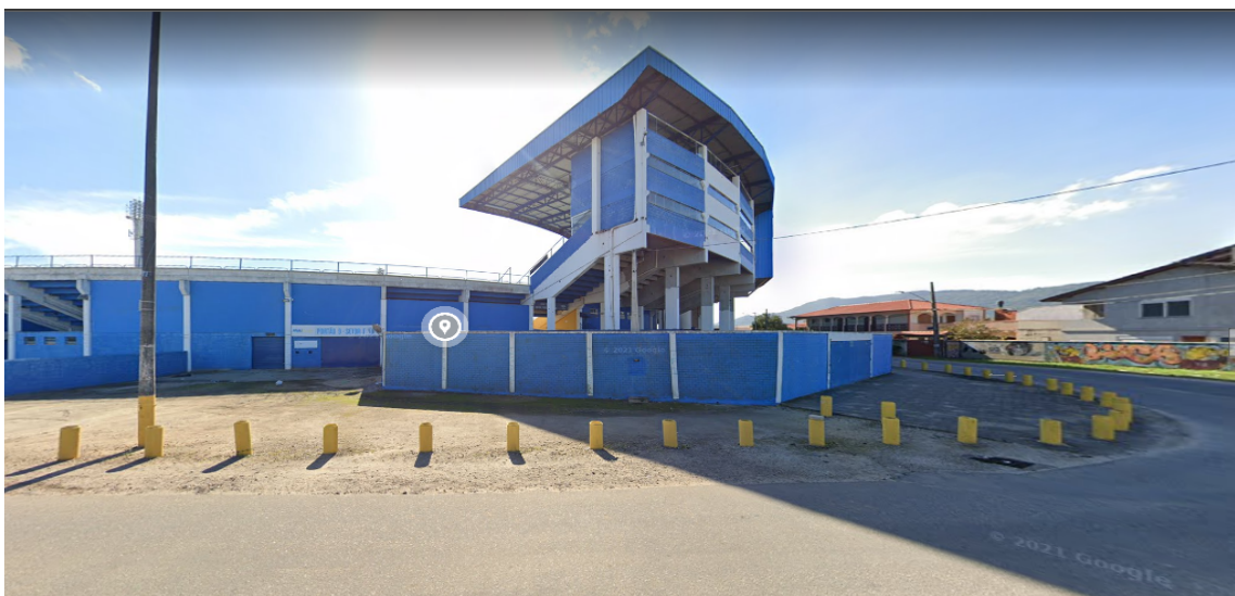
Imagem 5 – Lateral do Estádio da Ressacada
