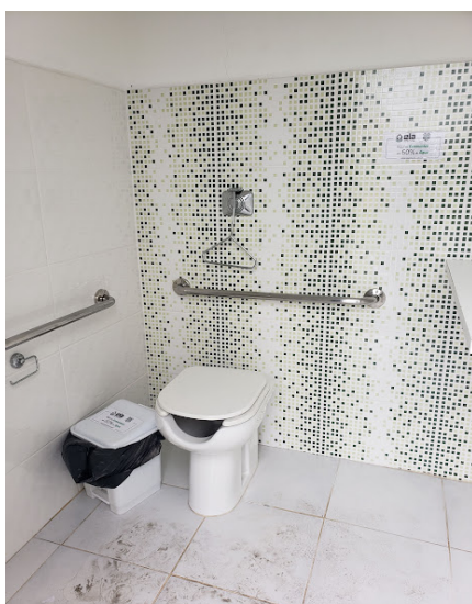
Imagem 17 - Banheiro adaptado do Estádio Orlando Scarpelli
