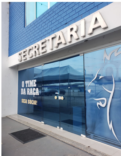
Imagem 21 - Sede administrativa da Ressacada.
