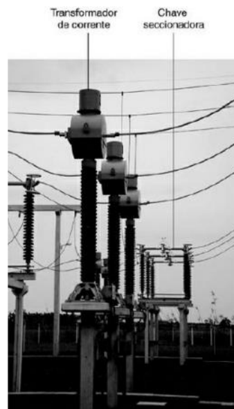
Figura 5. Transformador de corrente (TC)
