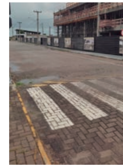
figura 15 - Novo empreendimento no vazio urbano. Fonte: Autor.
