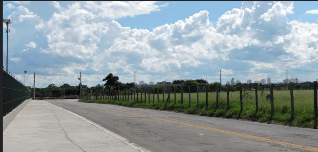
Figura 16: Foto do terreno, São José dos Campos, São Paulo. Fonte:Autor
