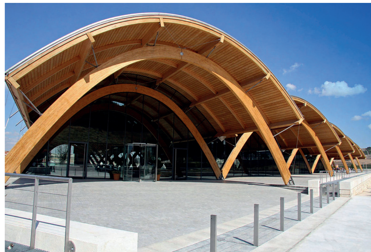
Estrutura em MLC, feita com peças curvas. Fonte: https://blogravprojects.wixsite.com/ravprojects/single-post/2017/03/09/madeira-laminada-colada-mlc-em-estruturas
