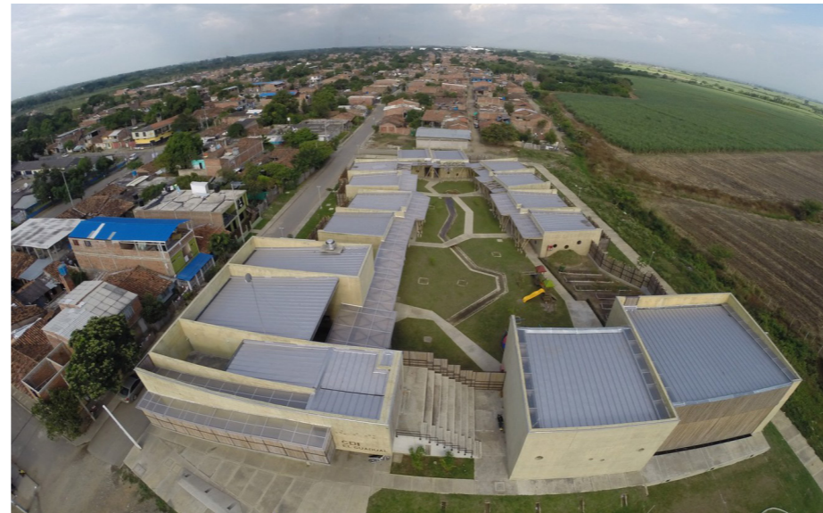
Figura 15 - Centro Infantil El Guadual - Villa Rica, Colômbia. Fonte: Archdaily, 2015.
