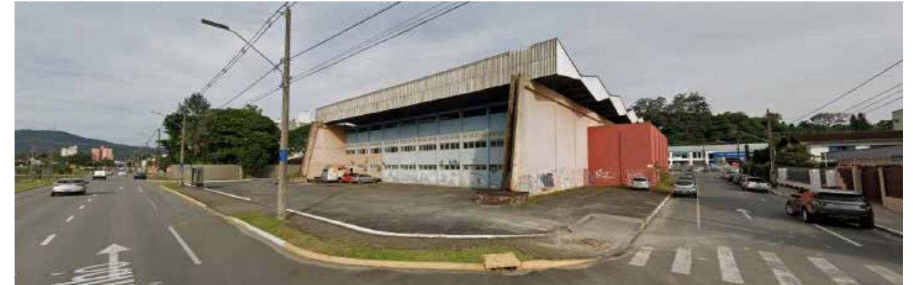
Ginásio visto da esquina da rua Timbó com a rua do Atleta. (Fonte: Google Earth)
