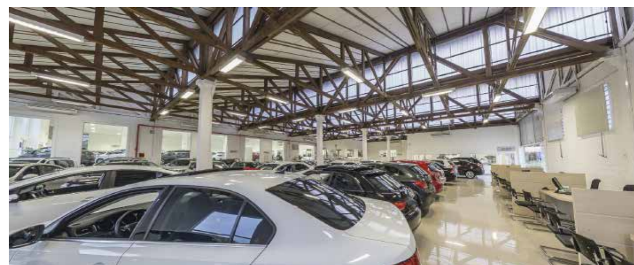
Galpão em anexo com treliças de madeira iluminação natural (Fonte: acervo do autor)
