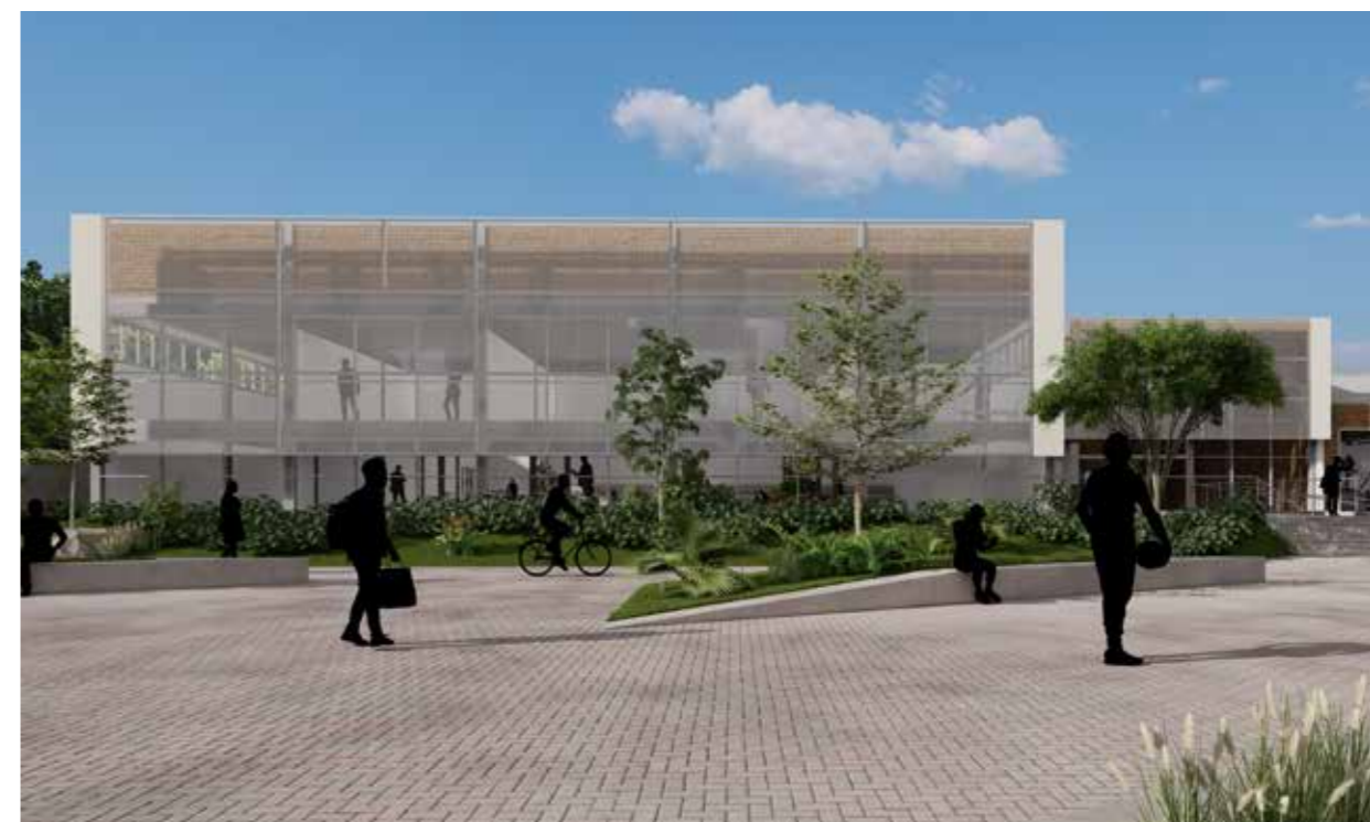
Parque aberto em frente ao galpão do complexo, que recebeu brises de chapa perfurada nas fachadas.
