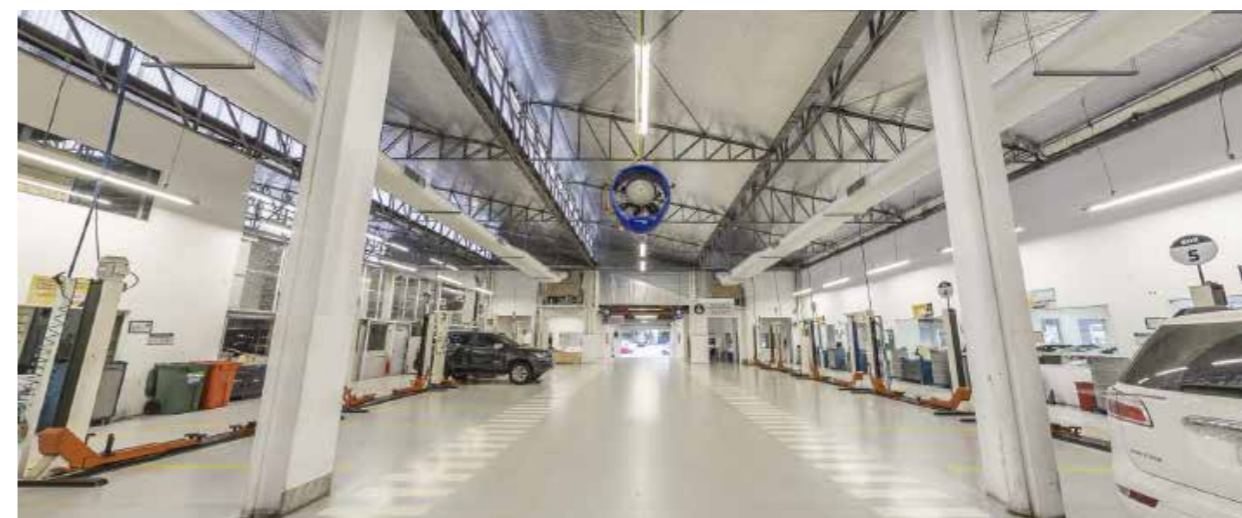
Galpão principal com treliças metálicas e iluminação natural (Fonte: acervo do autor)
