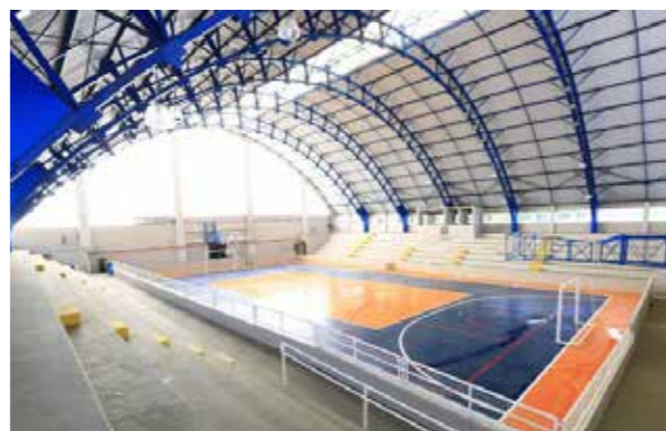
Interior do Ginásio Abel Schulz após a conclusão da reforma (Fonte: LJFS, 2019)
