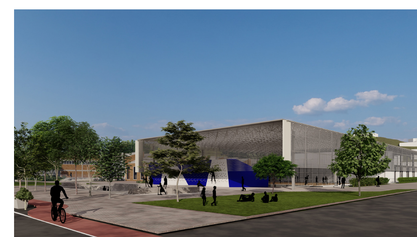
Parede de escada, pista de skate, e espaços vegetados em frente ao edifício novo, com brise horizontal na fachada principal e chapas perfuradas nas laterais, seguindo padrão utilizado no galpão principal.
