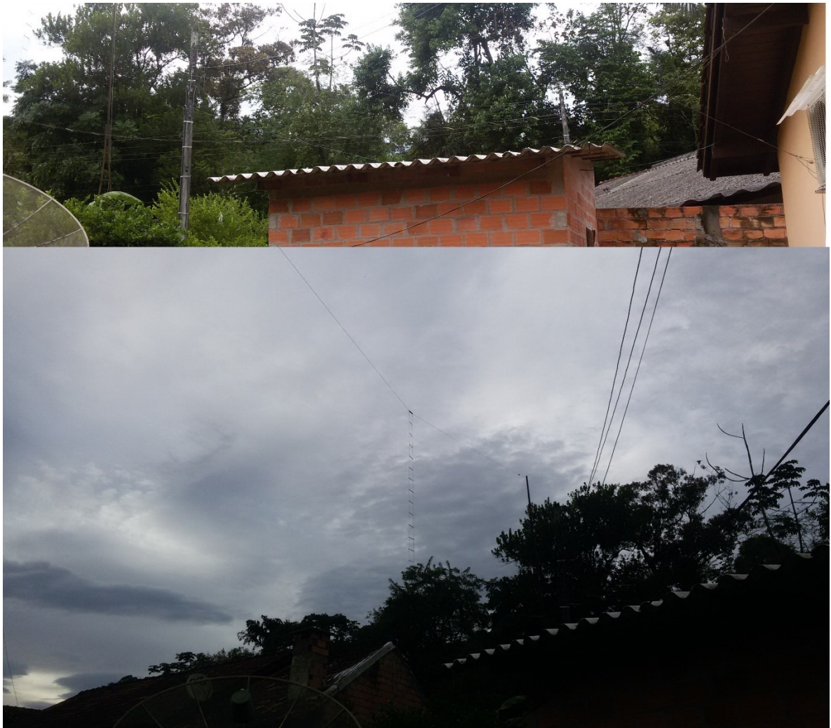
Figura 21- Linha de transmissão bifilar passando sobre edícula e subindo até o dipolo.
