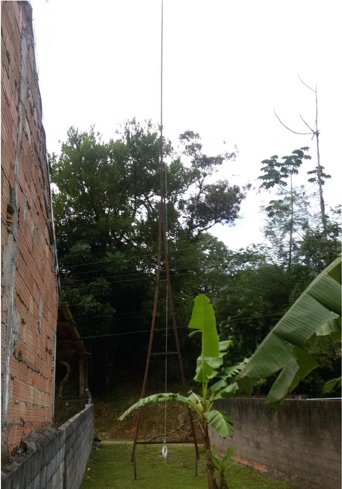
Figura 23- Um dos mastros de madeira tratada com 11 m de altura.
