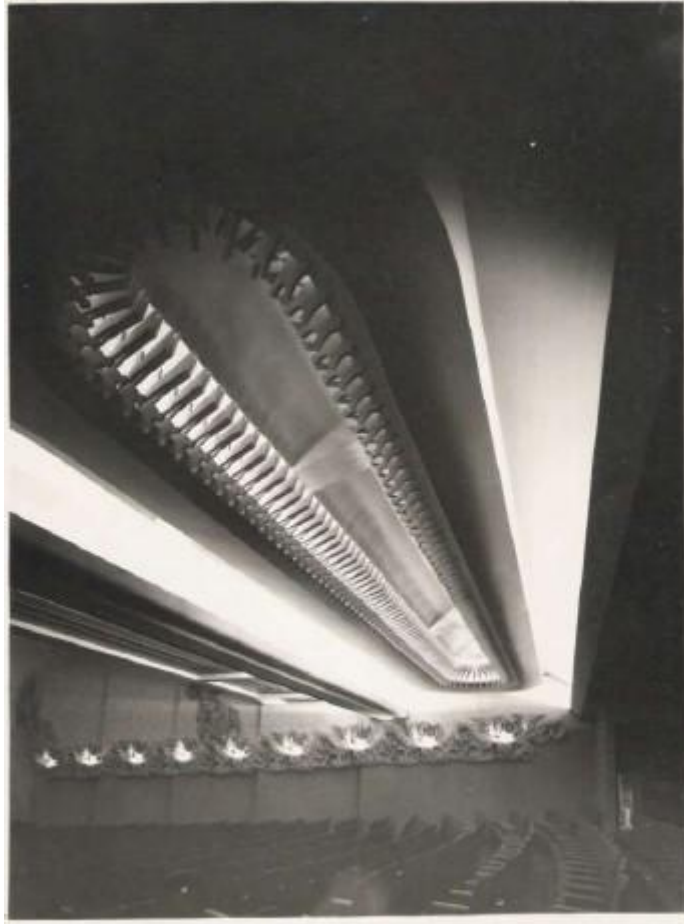
Figura 19 - Luminária central da platéia inferior do Cine São José.
