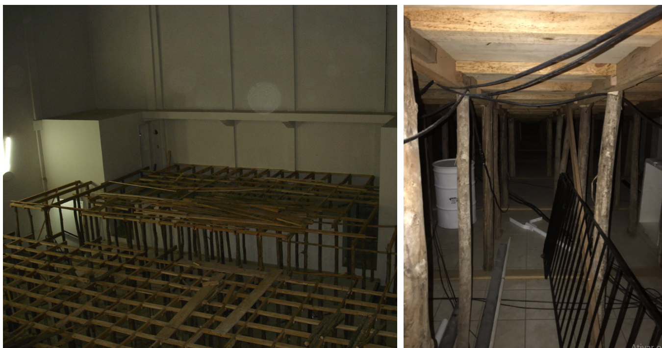
Figuras 36 e 37 - Nivelamento realizado pela igreja neopentecostal.
