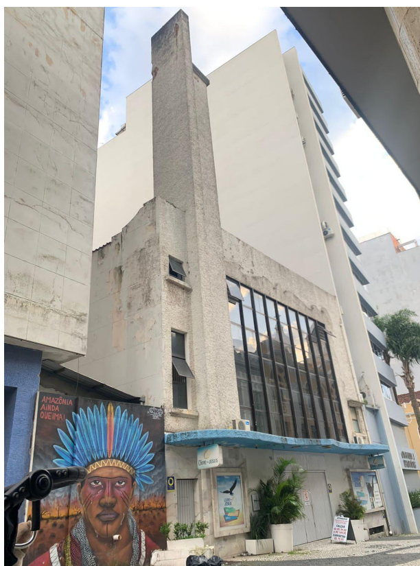
Figura 33 - Vista da entrada principal do Cine São José, na fachada oeste.
