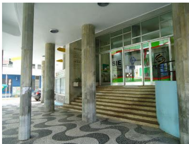
Figura 02 - Entrada do Edifício das Diretorias demarcada pela escadaria.
