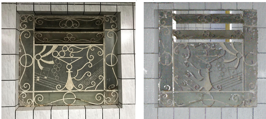
Figura 43 e 44 - Desenho da esquadria J-02 real vista interna (esquerda) e a esquadria fruto da nuvem de pontos vista externa (direita).
