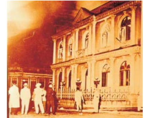
F13 - Incêndio de 1956 na ALESC
