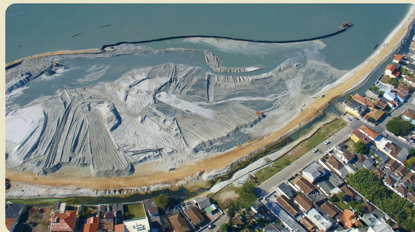
Figura 08 - Imagem aérea realizada durante as obras de aterro da Beira-mar Continental. Foco na área próxima à Ponta do Leal, onde o aterro se estendeu cerca de 60 metros em direção ao mar. Fonte: HUESKER BRASIL (2016)
