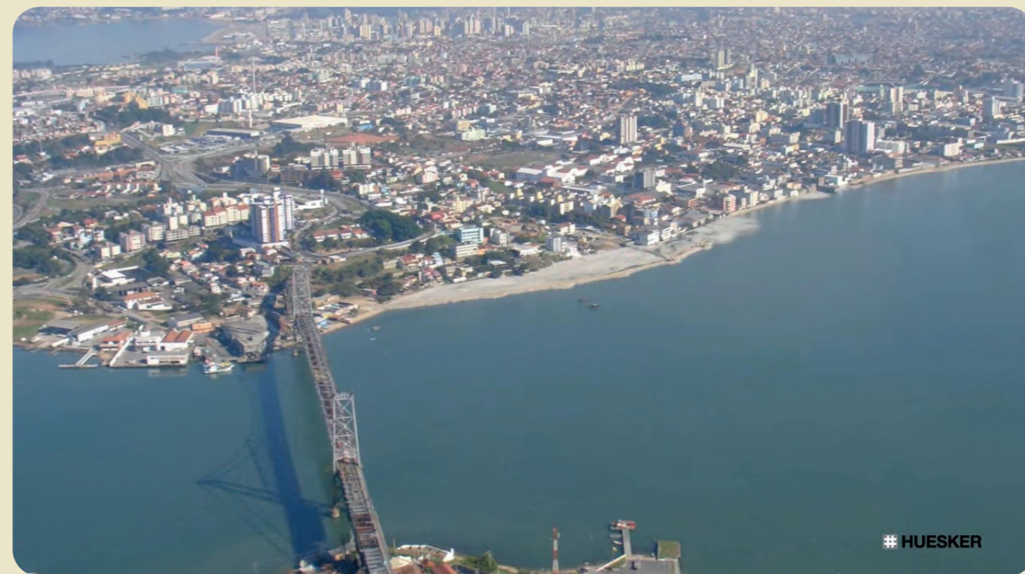
Figura 07 - Imagem aérea realizada durante as obras de aterro da Beira-mar Continental, iniciadas no ano de 2004. Fonte: HUESKER BRASIL (2016)
