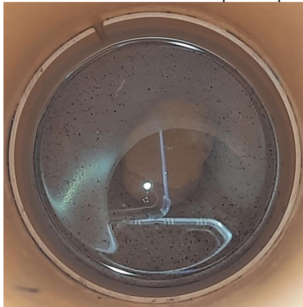
Figura 8 - Esponja sobre a camada filtrante com uma pedra impedindo a sua flutuação
